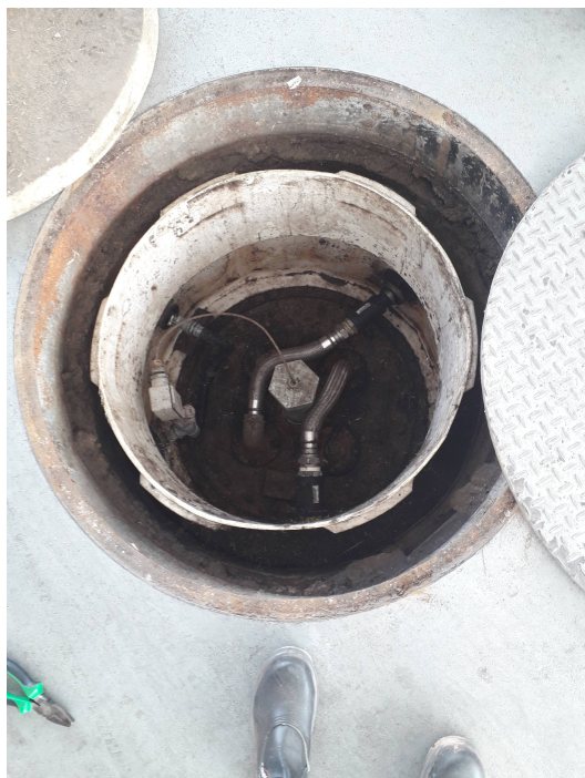
Figura 9. Área de visita do tanque de abastecimento de combustível (diesel S10)
