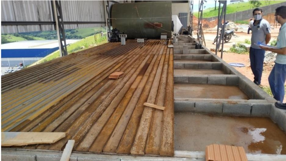
**Figura 4. Sistema de moldes para fabricação das lajes (14/12/2020).**
