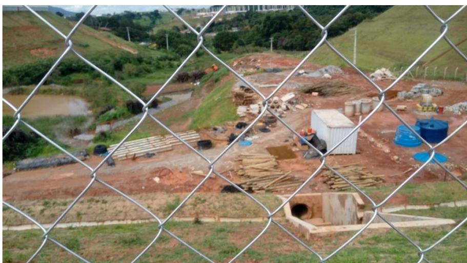
**Figura 6. Drenagem de água pluvial (escada hidráulica) que está vinculada a coleta de água que incide sobre o galpão C.**
