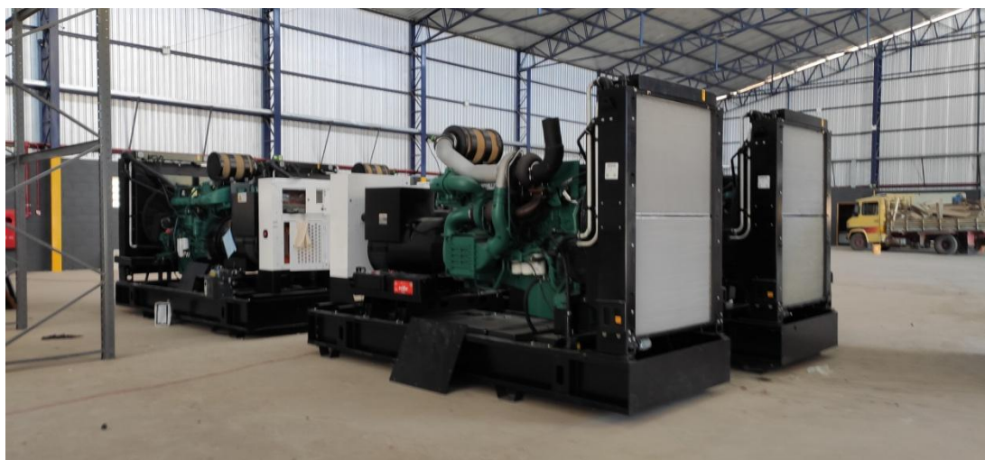
Figura 12. Montagem dos geradores.
