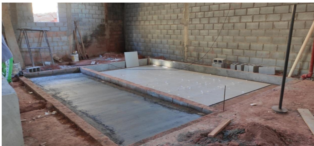
Figura 5. Área para tratamento superficial, antes da finalização da instalação.
