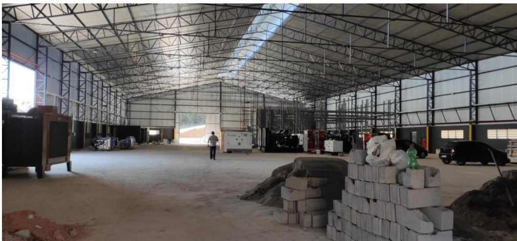
Figura 1 . Área interna do empreendimento antes da finalização das instalações.
