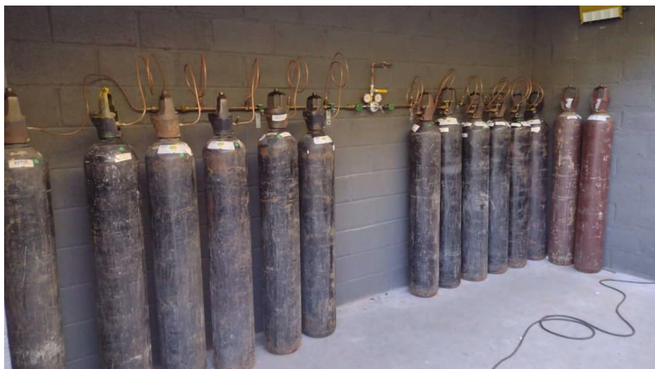
Figura 18. Armazenamento de cilindros de oxigênio e argônio. (Fonte: Informação complementar)
