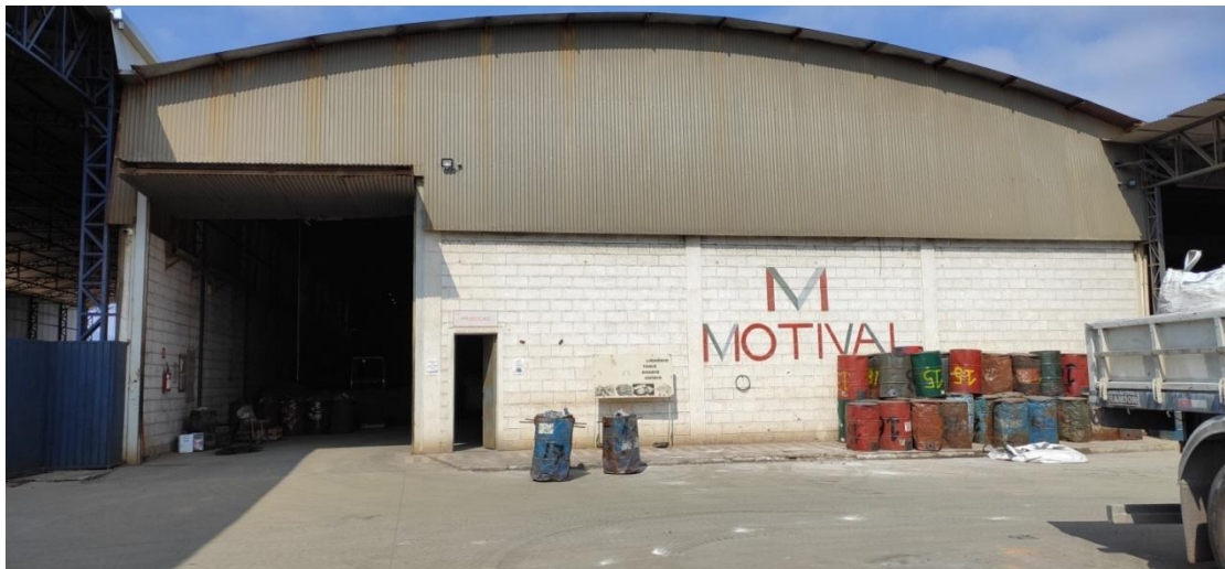
Figura 1. Vista frontal do galpão de produção.
