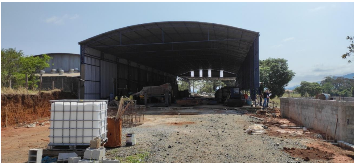
Figura 15. Vista da área aos fundos no novo galpão do empreendimento.
