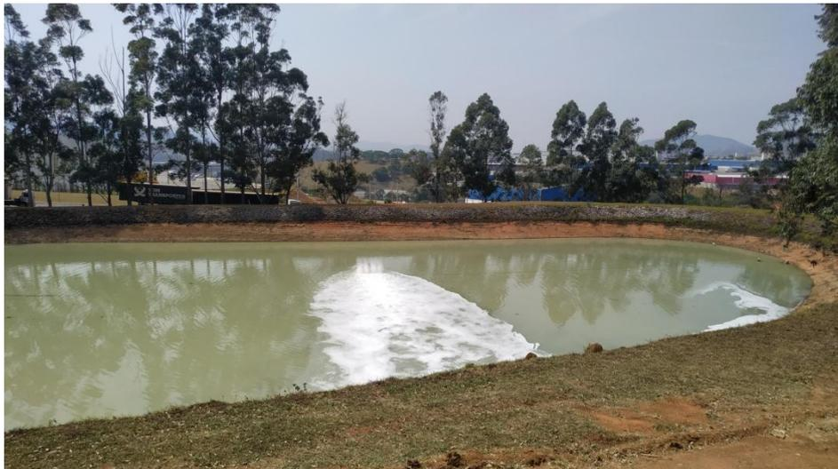
**Figura 18. Vista do lançamento do efluente tratado da ETE em lagoa de estabilização e percolação**
