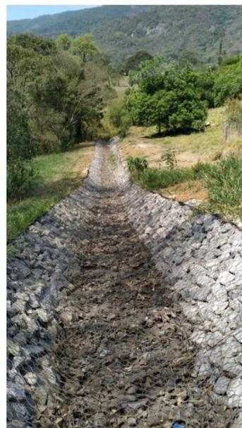
**Figura 10. Dissipador de energia de águas pluviais.**
