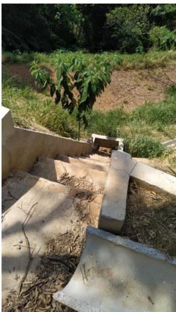
**Figura 9. Escada hidráulica componente do sistema de drenagem de águas pluviais.**
