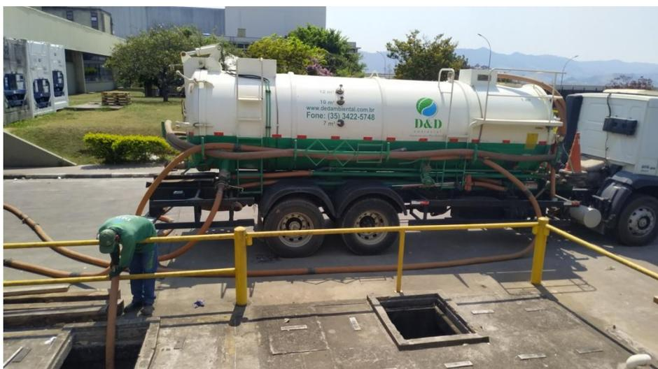
Figura 16. Evidência de limpeza da caixa de gordura.
