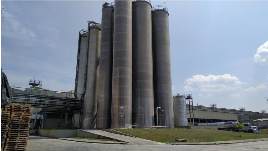
**Figura 11. Silos de armazenamento de farinha, açúcar e gordura.**
