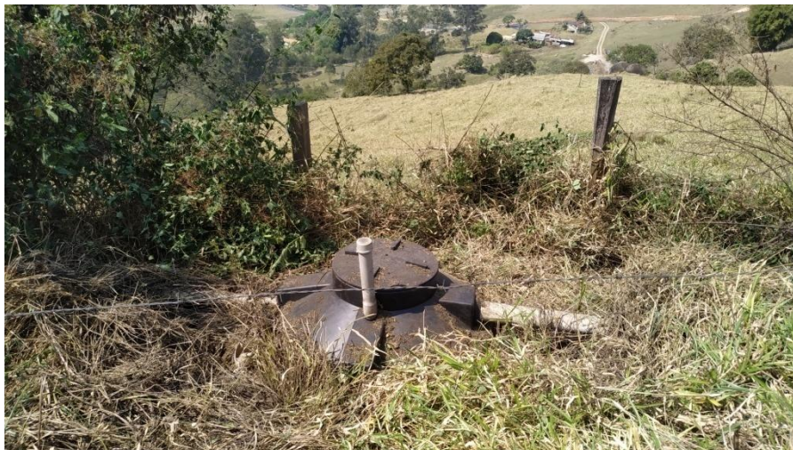
Figura 12. Sistema de tratamento de efluentes sanitários (biodigestor) do empreendimento
