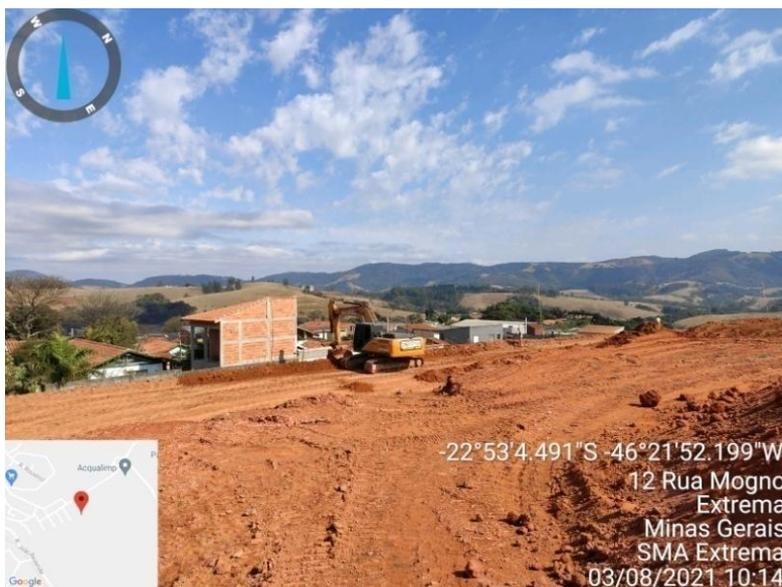
Figura 9. Terraplanagem em execução na Matrícula 11.610, divisa com as residências do bairro Mantiqueira.
