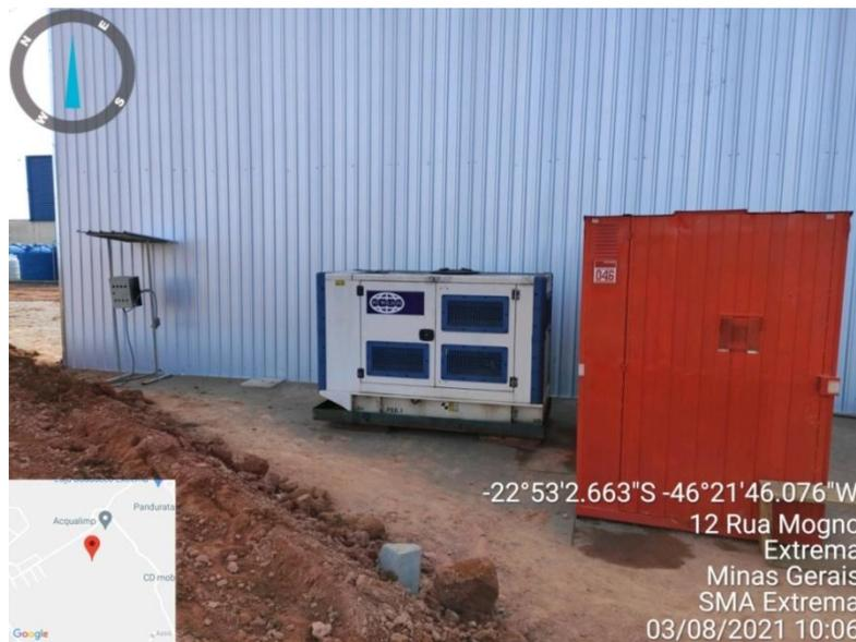
Figura 3. Gerador a diesel.
