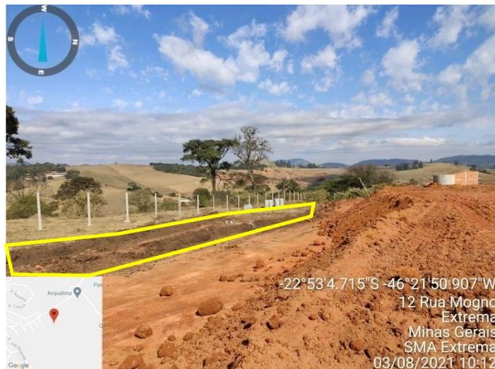
**Figura 16. Canaletas de contenção de processos erosivos da terraplenagem (em destaque)**
