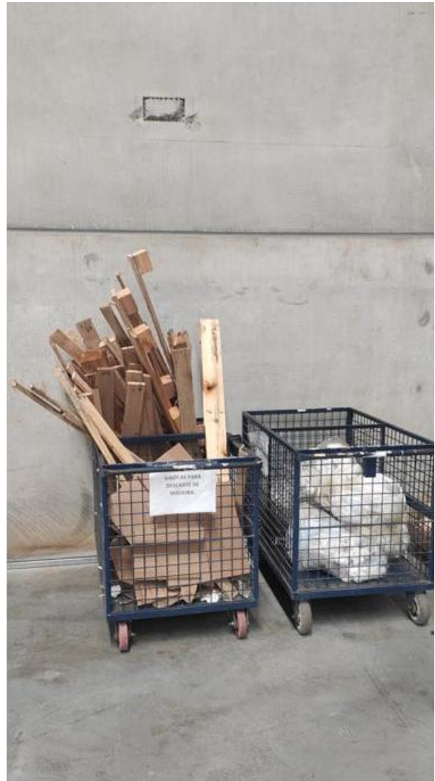
Figura 12. Gaiolas de armazenamento interno de resíduos de madeira de plásticos.
