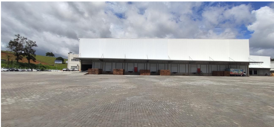
Figura 1. Vista frontal do galpão do empreendimento.
