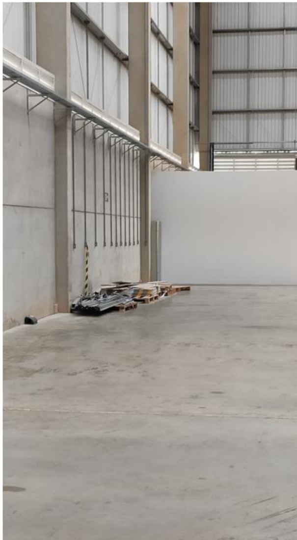
Figura 11. Área de instalação da sala de baterias
