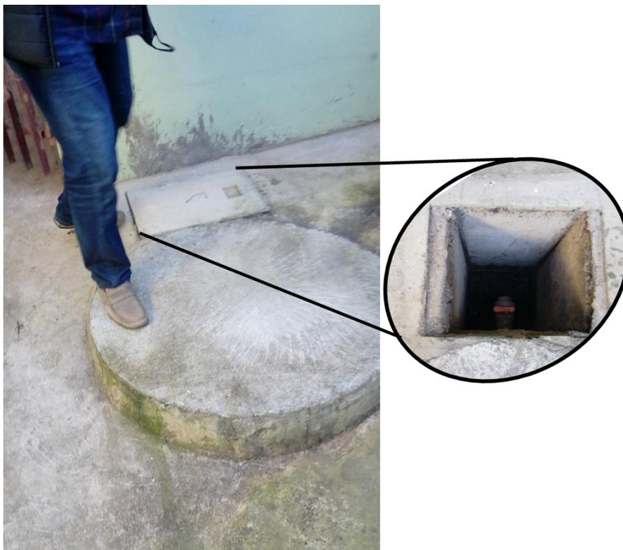
**Figura 15.** Local do sistema de tratamento de efluentes (biodigestor), juntamente com caixa de limpeza, nas dependências da Casa da Lavoura, próximo ao ponto de embarque-desembarque dos funcionários.
