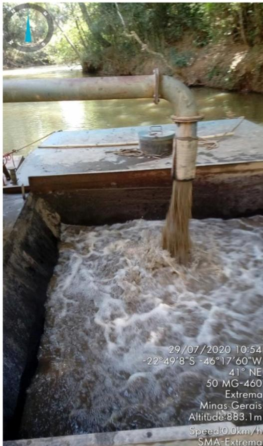
Figura 7. Coleta e lançamento da polpa dragada no batelão.
