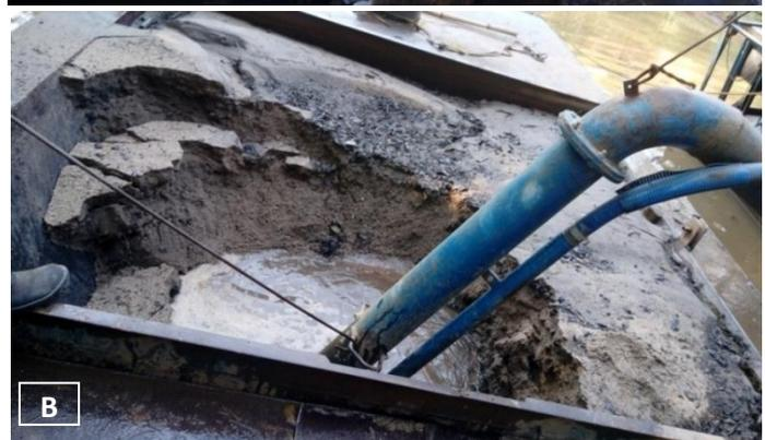
Figura 8 (A) e (B). Sucção da polpa mineraria do batelão para o porto de areia.
