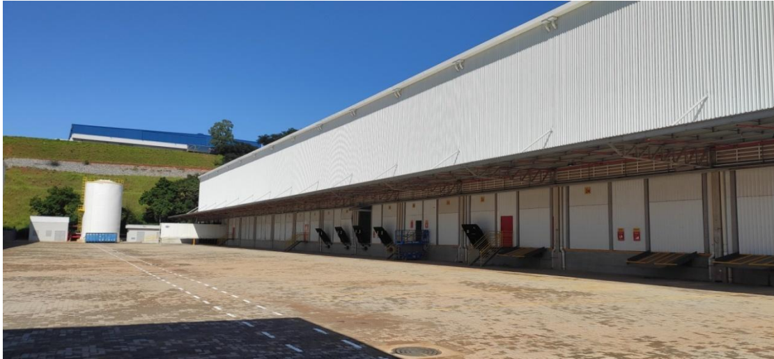
Figura 1. Vista frontal do galpão do empreendimento.
