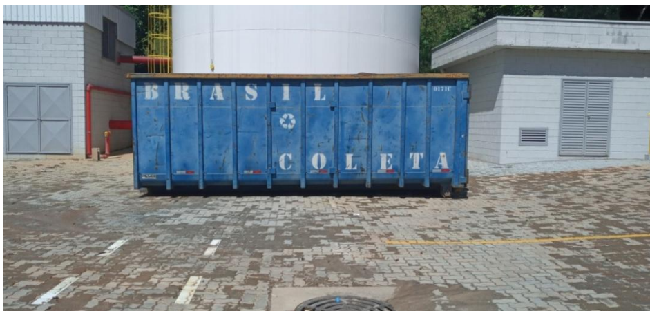
Figura 10. Caçamba localizada na área externa para armazenamento transitório de recicláveis.
