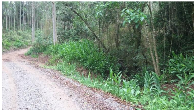
Figura 9. Estrada local estabelecida ao lado do Córrego dos Forjos
