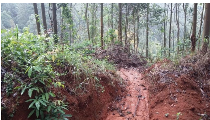
Figura 3. Estrutura de aceiro e drenagem
