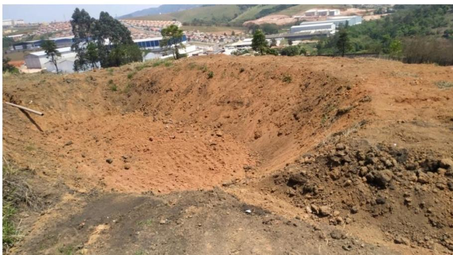
**Figura 8. Vista da Bacia 4 de infiltração/decantação.**
