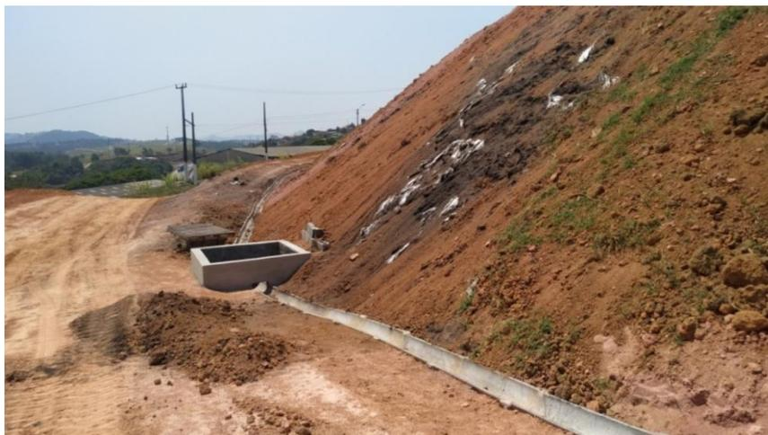
Figura 10. Vista das canaletas de drenagem e caixa de passagem na base do aterro.
