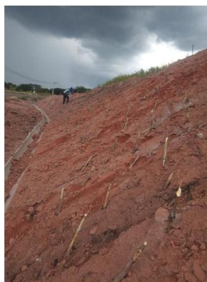
Figura 13. Plantio de capim napier para cobertura dos taludes.
