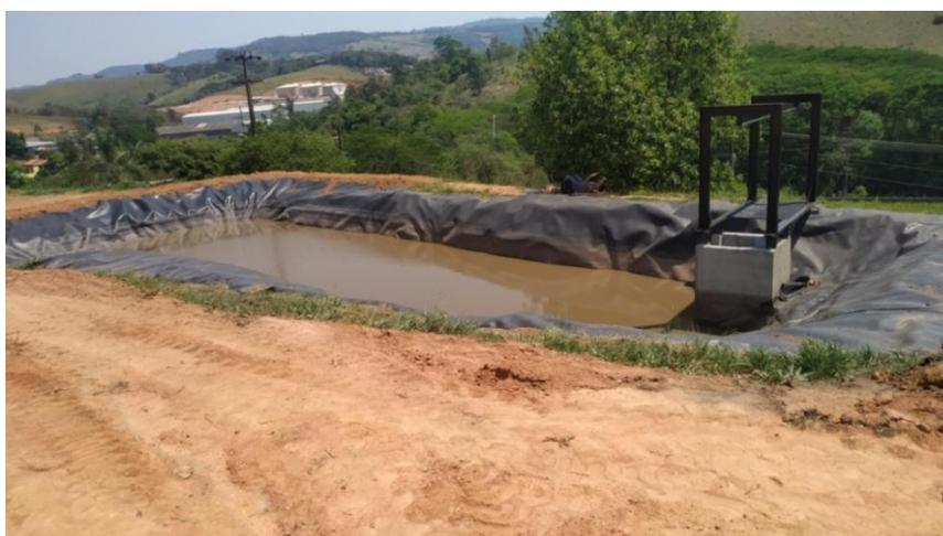
Figura 11. Vista da Bacia 1, onde foi instalado sistema moto-bomba para recirculação do efluente/água.
