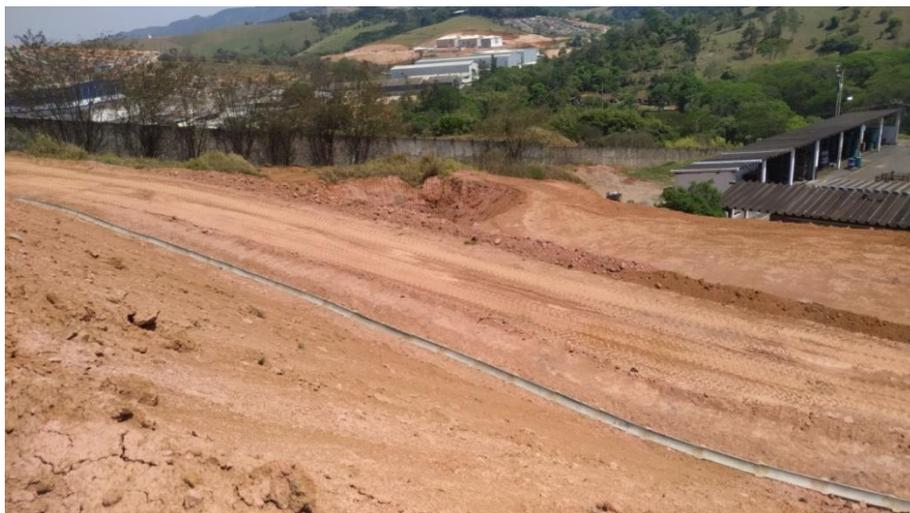
**Figura 7. Vista da canaleta de drenagem instalada na base da pilha 2.**
