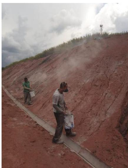
Figura 12. Lançamento de sementes de braquiária para cobertura dos taludes e bermas.
