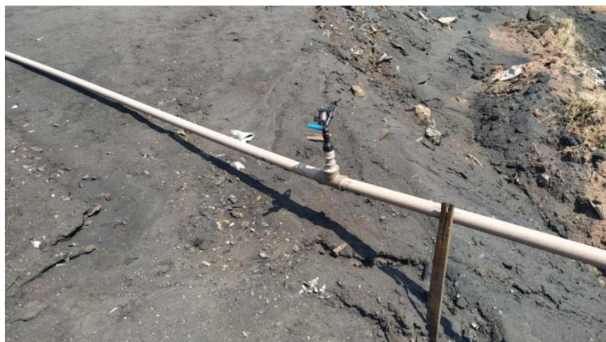
**Figura 3. Sistema de aspersão instalado no aterro.**
