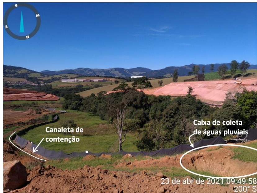
Figura 5. Vista da nascente e área brejosa, com cercamento com manta geotêxtil, vala de contenção em caso de processos erosivos e caixas provisórias de coleta de água pluvial
