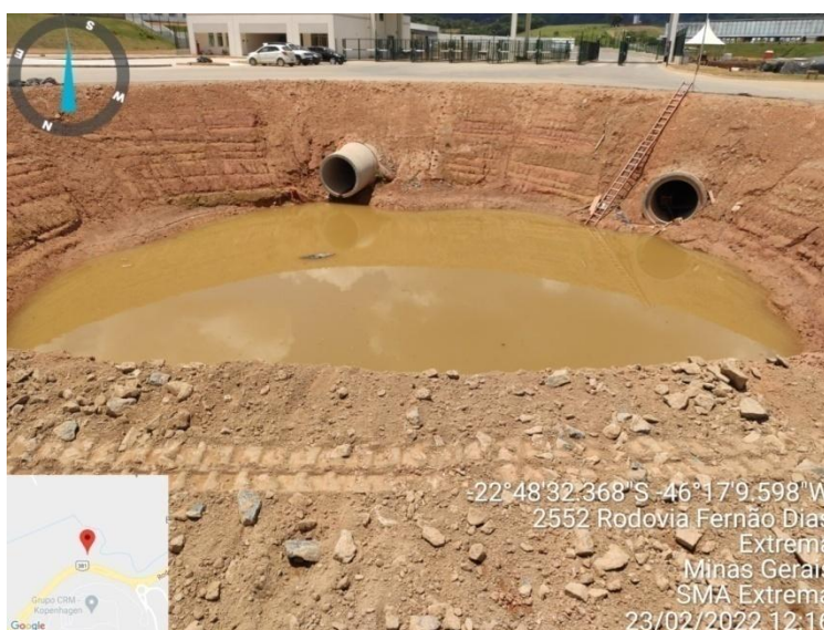
Figura 39. Tanque de Retardo 3 em execução
