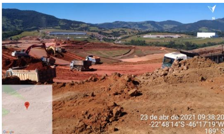
Figura 2. Frente de corte de solo.
