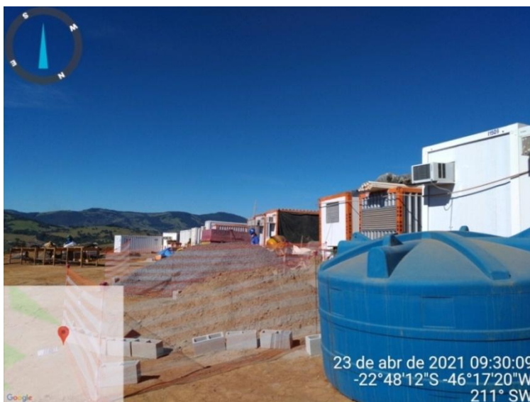
Figura 23. Armazenamento de materias para instalação do muro de arrimo.
