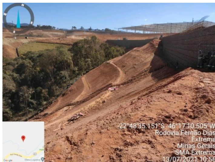
Figura 28. Muro de gabião e formação de taludes e escada hidráulica, próximo a nascente e curso hídrico interno, localizado na porção do Sudoeste do empreendimento
