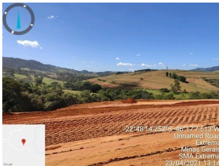
Figura 19. Área de execução de terraplanagem a Nordeste do empreendimento
