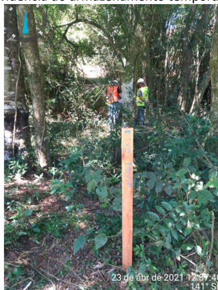
Figura 14. Delimitação do Eixo Central da ponte que dará acesso ao empreendimento pela Rod. Fernão Dias.
