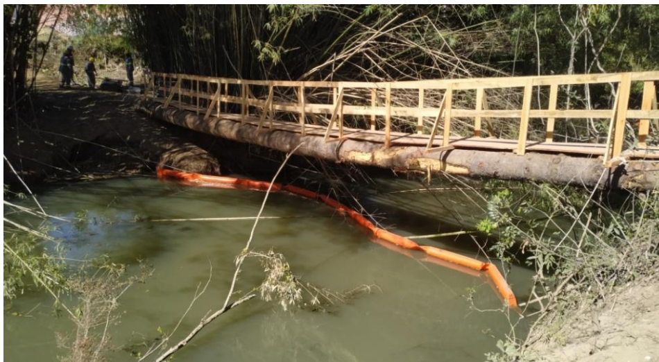
Figura 34. Boias de contenção instaladas no Rio Camanducaia
