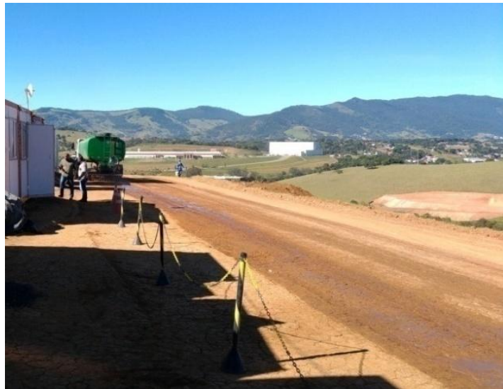
Figura 21. Vista parcial do canteiro de obras e evidência de uso de água para aspersão no solo (redução da emissão de particulados da movimentação de maquinários).
