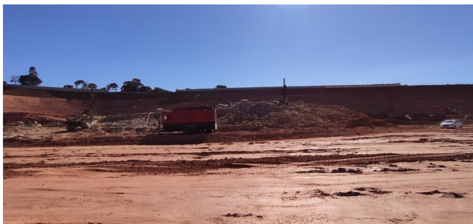
Figura 35. Região de detonação de rochas
