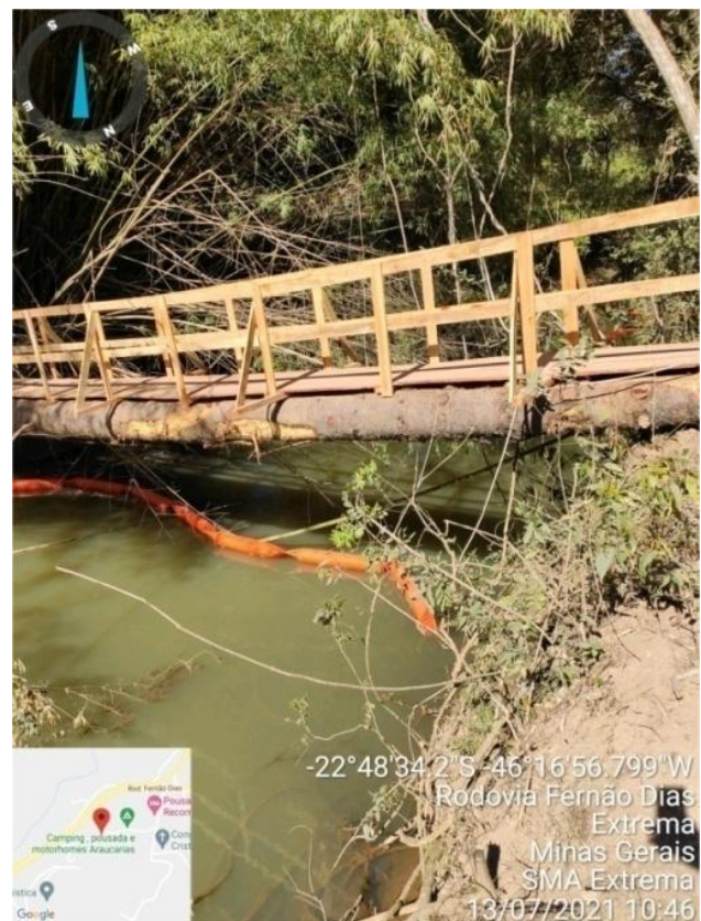
Figura 9. Instalação de bóias de contenção no trecho do leito Rio Camanducaia
