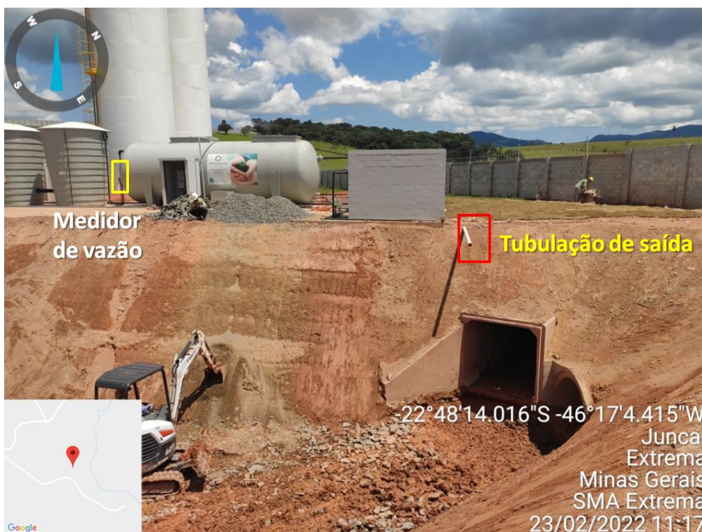
Figura 44. ETE sanitária do condomínio instalada, com tubulação direcionada para o Tanque de retardo de águas pluviais 4.
