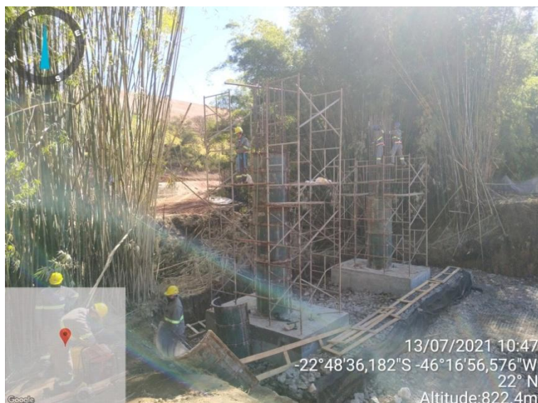
Figura 31. Vista da construção dos pilares de sustentação da ponte, na lateral esquerda do Rio Camanducaia
