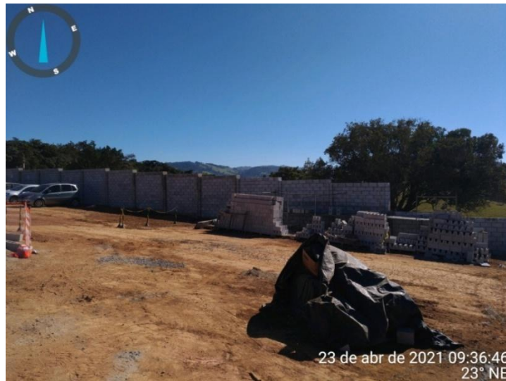
Figura 20. Frente de trabalho de execução de muro de arrumo no perímetro do empreendimento.
