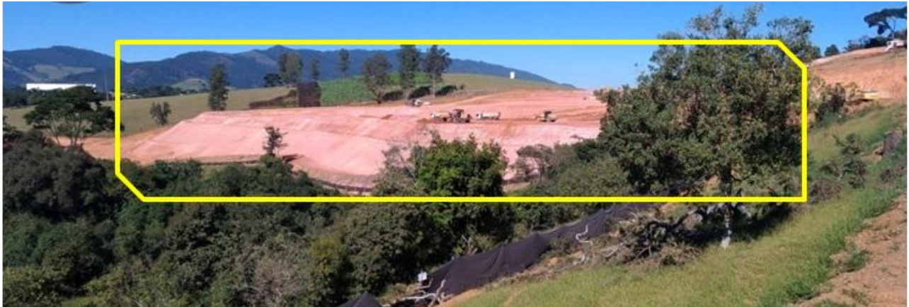
Figura 17. Área de terraplanagem e formação de platô para instalação do galpão G500
