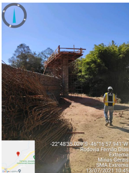
Figura 32. Vista da construção dos pilares de sustentação da ponte, na lateral direita do Rio Camanducaia
