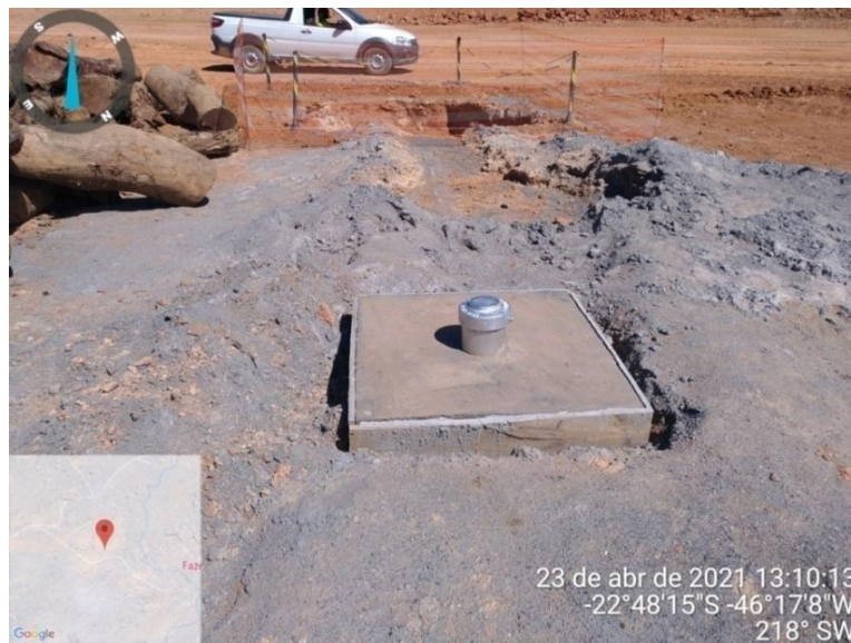
Figura 18. Poço Tubular perfurado na face nordeste do empreendimento.
