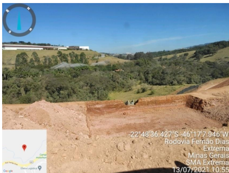
Figura 29. Escavação do tanque de retardo da porção Sul do empreendimento (próximo ao futuro acesso e guarita)
