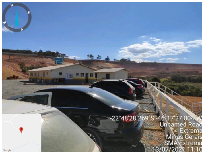
Figura 25. Vista parcial do canteiro de obras final
