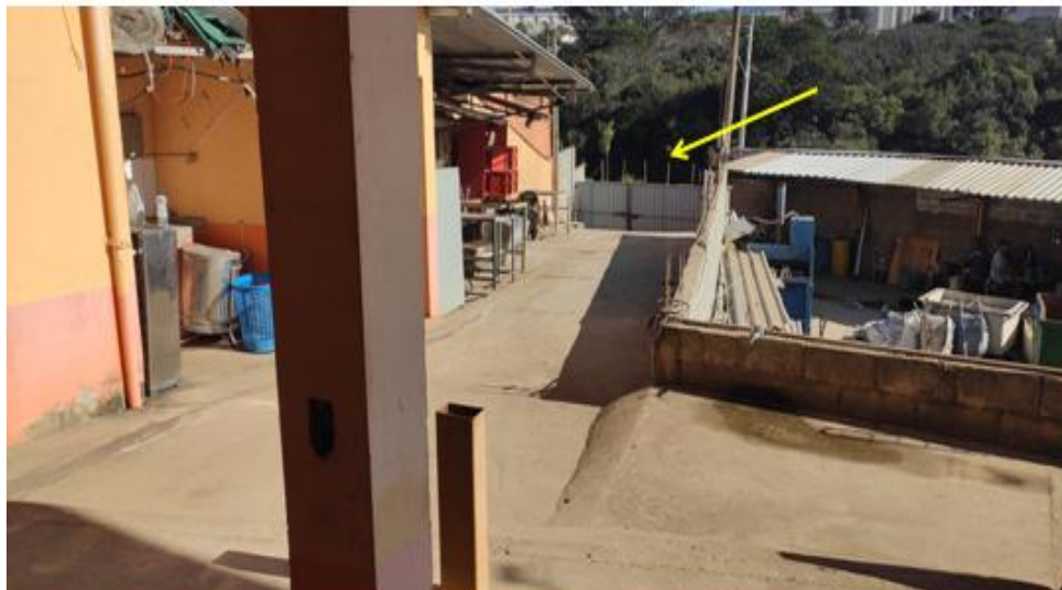
Figura 2. Portão lateral de recebimento de resíduos eletroeletrônicos.
