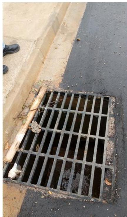
Figura 8. Ponto final da galeria de águas pluviais do empreendimento previamente ao lançamento na via local (Estrada Municipal Vereador José Lamartine de Oliveira)
