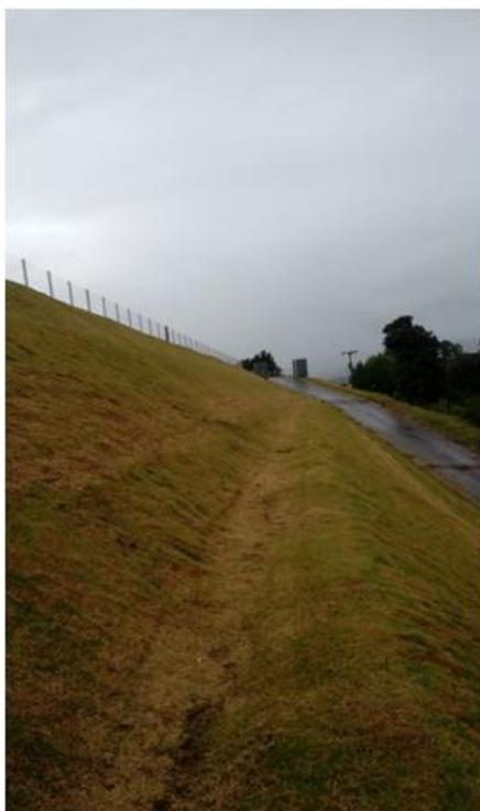
Figura 7. Talude revegetado
