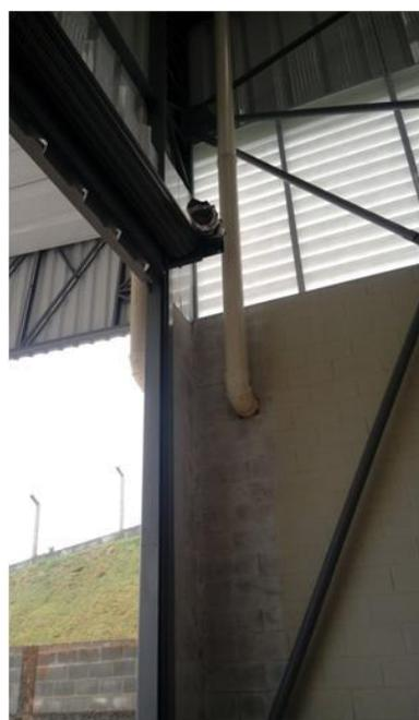
Figura 4. Tubulação de coleta de águas pluviais do telhado
