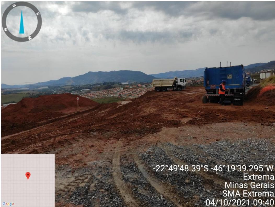
Figura 8. Execução de terraplanagem na face Sul do terreno
