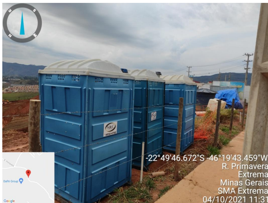
Figura 2. Sanitários móveis (banheiros químicos) do canteiro de obras 1.
