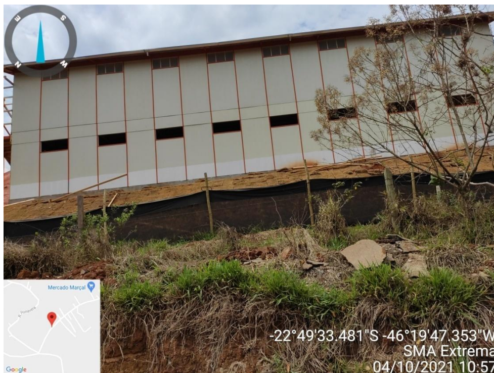
Figura 3. Canteiro de obras 2 (permanente)
