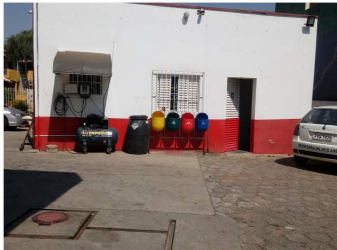
Figura 6. Visão do local de equipamento de compressão de ar e coleta de resíduos
