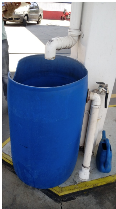
Figura 12. Tambor de coleta de água pluvial para limpeza da pista de abastecimento
