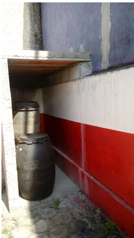
Figura 11. Área coberta de armazenamento de embalagens e EPIs contaminados
