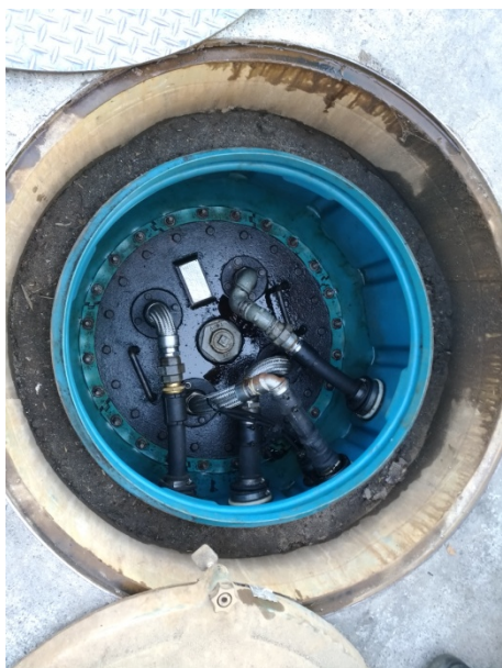
Figura 6. Boca de Visita do Tanque 4-Diesel
