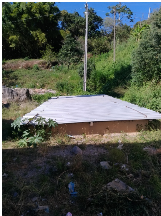
Figura 25. Sistema de tratamento de efluentes sanitários do empreendimento.
