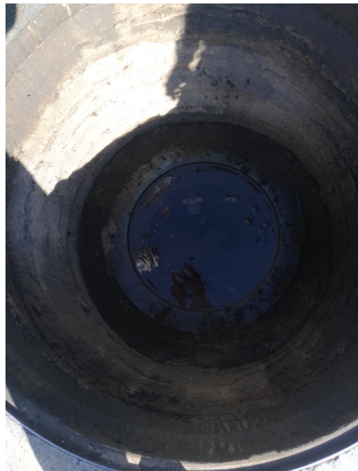
Figura 17. Sistema SAO – Saída do efluente tratado para rede de drenagem
