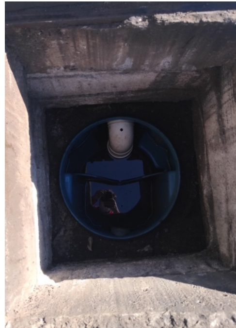
Figura 15. Sistema SAO - Separação
