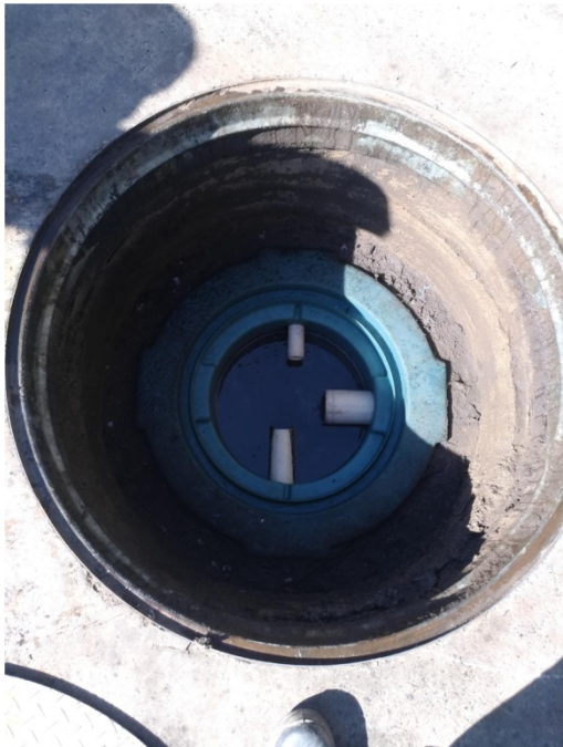
Figura 14. Sistema SAO – Entrada do efluente
