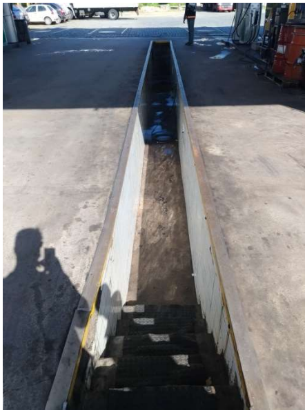
Figura 9. Vala de troca de óleo no interior da pista de abastecimento
