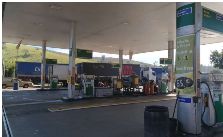
Figura 2. Vista geral da pista de abastecimento
