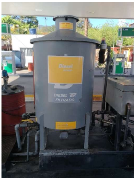
Figura 11. Um dos filtros de Diesel do SASC
