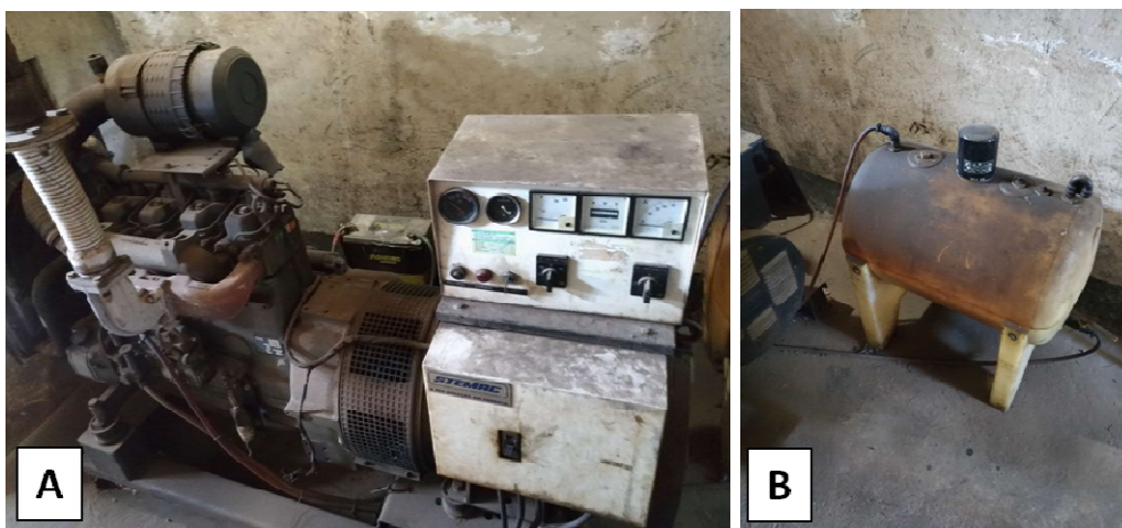
Figura 19. Gerador de energia (A) movido a diesel e tanque de combustível do gerador (B)
