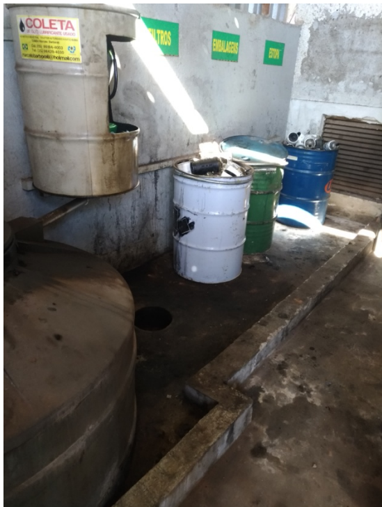
Figura 22. Área de armazenamento de óleos lubrificante, embalagens e EPIs contaminados
