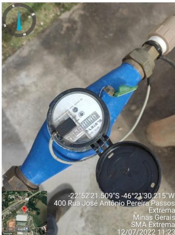
Figura 22. Poço tubular subterrâneo
