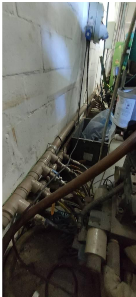
Figura 14. Sistema de tubos de refrigeração das injetoras
