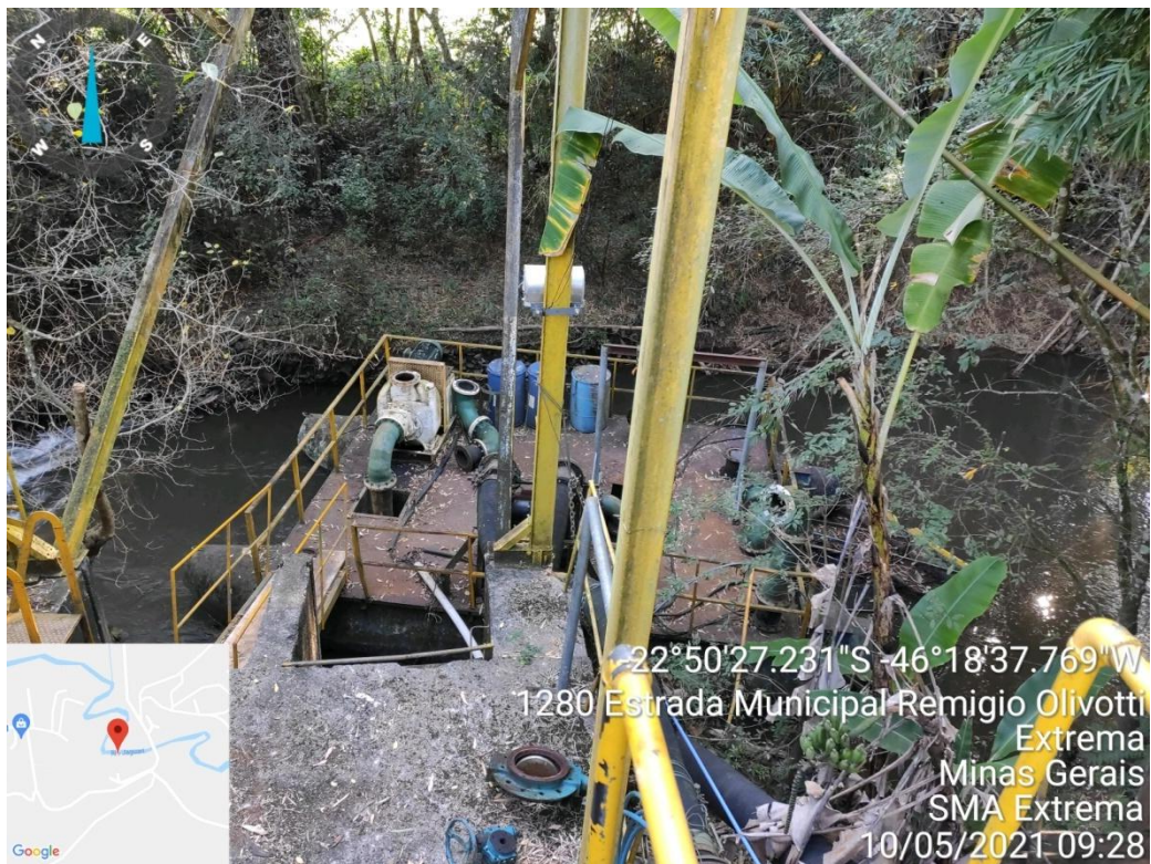
Figura 1 . Balsa flutuante de captação de água bruta no Rio Jaguari
