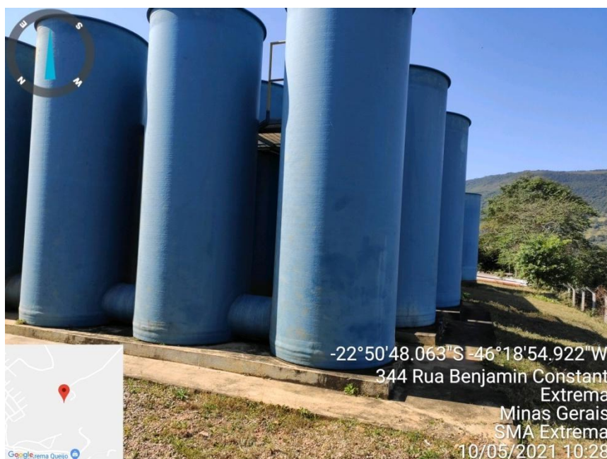
Figura 7. Sistema de decantação do Tratamento da ETA Jaguari II
