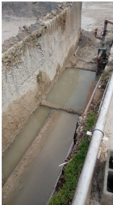
Figura 2. Caixas de decantação de sólidos.
