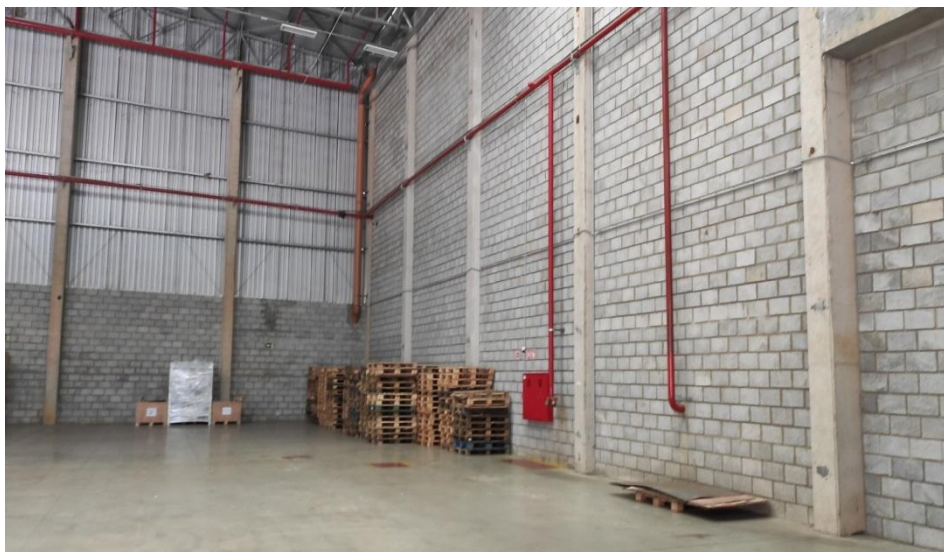
Figura 4. Local de armazenamento de paletes e recicláveis no interior do empreendimento
