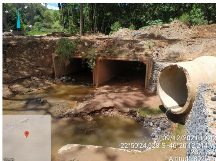
Figura 18. Tubulação de lançamento de águas pluviais e efluentes sanitários tratados no corpo receptor.
