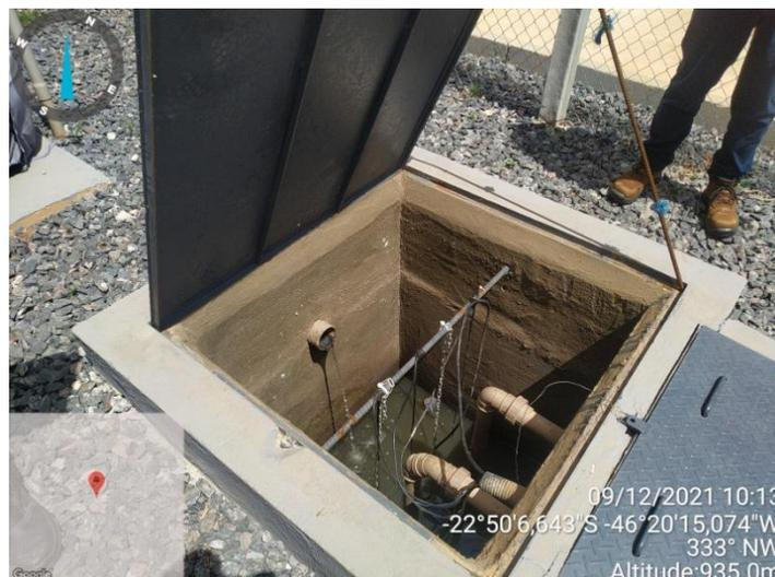
Figura 14. Estação elevatória de esgotos (EEE) na área da ETE do empreendimento.
