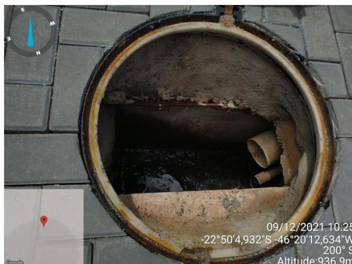
Figura 15. Ponto de ligação da rede de esgotos tratados na rede de drenagem de águas pluviais.
