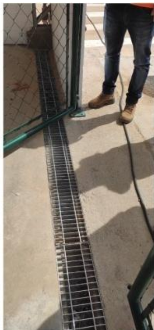
Figura 19. Destaque grelhas de contenção
