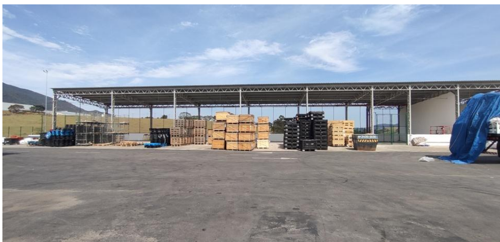
Figura 16. Central de resíduos nova (antes das adequações)
