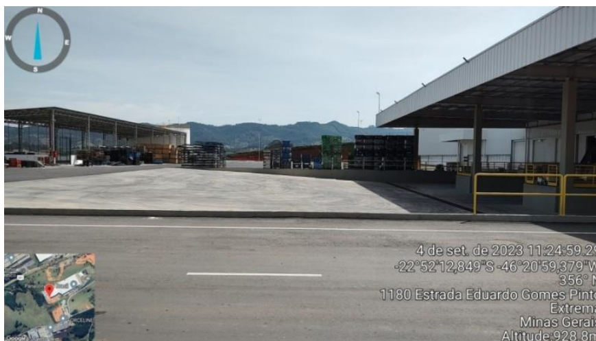
Figura 2. Docas de recebimento da ampliação (a direita) e central de resíduos (a esquerda)
