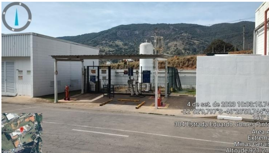
Figura 11. Ponto de armazenamento e abastecimento empilhadeiras movidas a GLP
