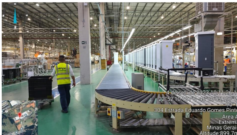
Figura 8. Esteira onde será instalados os equipamentos de montagem da linha 2 de refrigeradores
