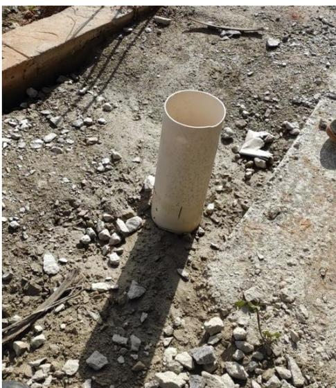
**Figura 11. Tubulação em instalação para interligação da coleta de águas pluviais providas do telhado.**
