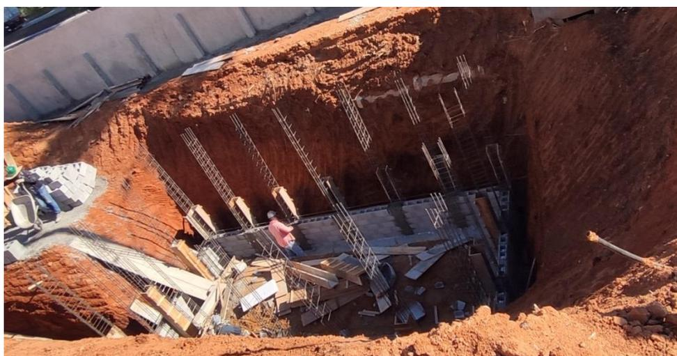
**Figura 4. Instalação de estrutura de tanque de contenção de águas pluviais.**
