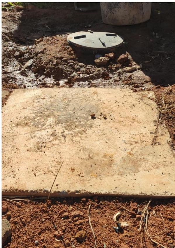
**Figura 2. Biodigestor do canteiro de obras com capacidade de 1.000 litros.**
