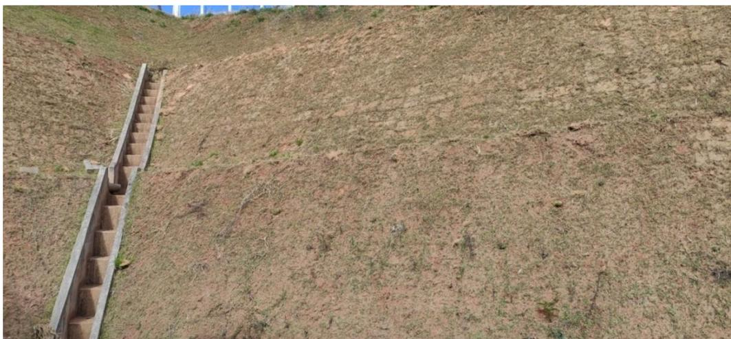
**Figura 10. Parcela Sul da área de talude vegetada e escada hidráulica**
