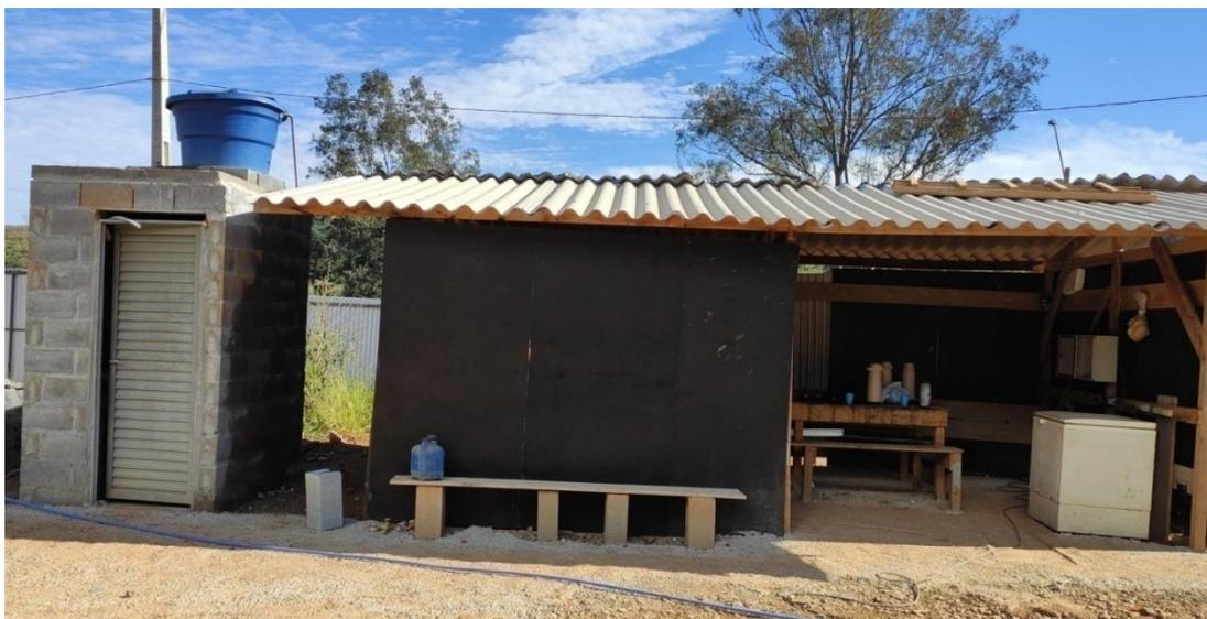
**Figura 1. Canteiro de obras e sanitário provisórios.**
