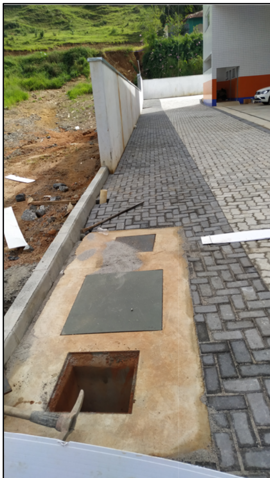
Figura 5. Caixa separadora de água e óleo (CSAO) instalada no empreendimento.
