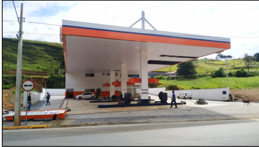
Figura 1. Vista frontal do posto de abastecimento em instalação.
