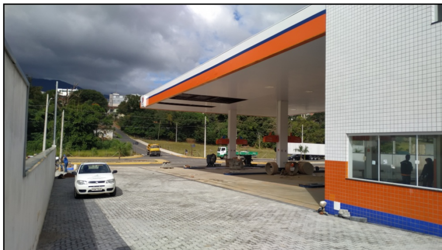
Figura 3. Vista lateral direita do empreendimento (acesso de veículos de descarga de combustíveis).
