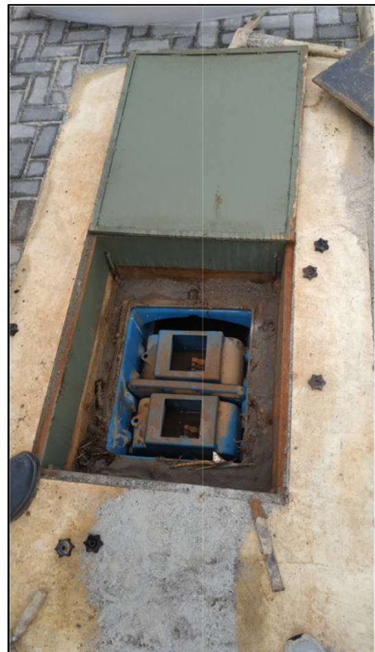
Figura 5. Caixa separadora de água e óleo (CSAO) instalada no empreendimento.
