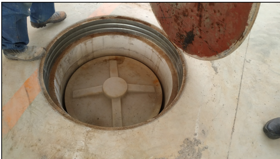
Figura 7. Boca de visita dos tanques.
