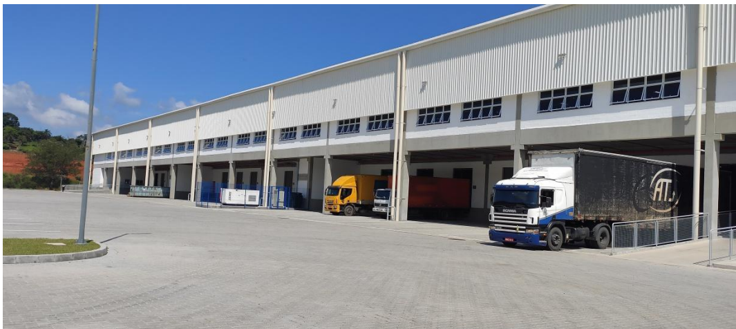
Figura 1. Visão geral da área externa empreendimento
