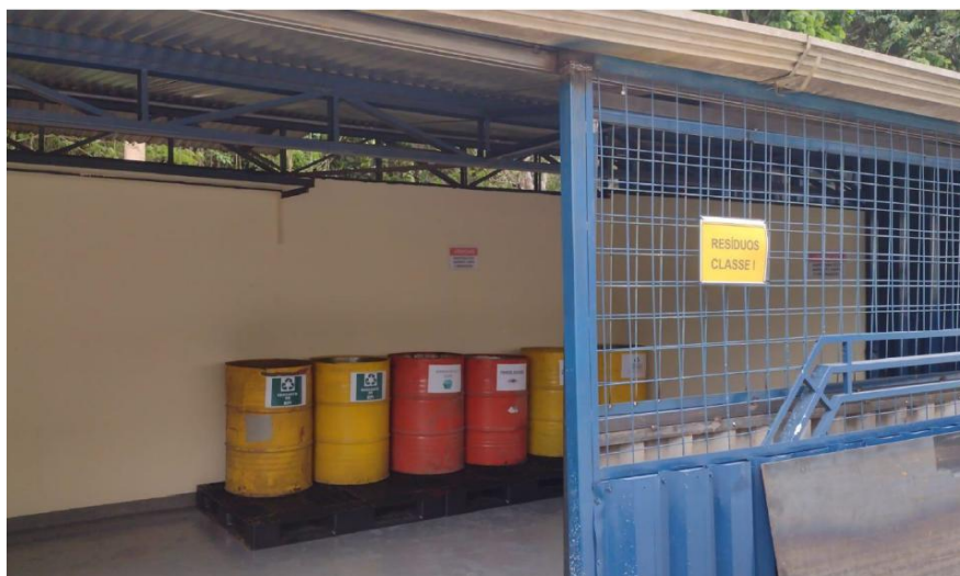
Figura 26. Área de armazenamento de Resíduos Classe I - após adequação. Fonte: Empresa
