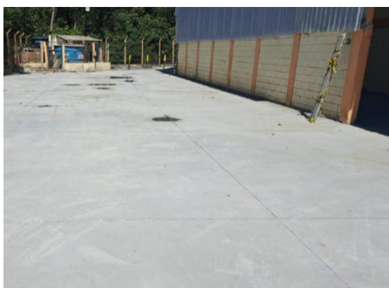
Figura 21. Área externa após adequação. Fonte: SMA
