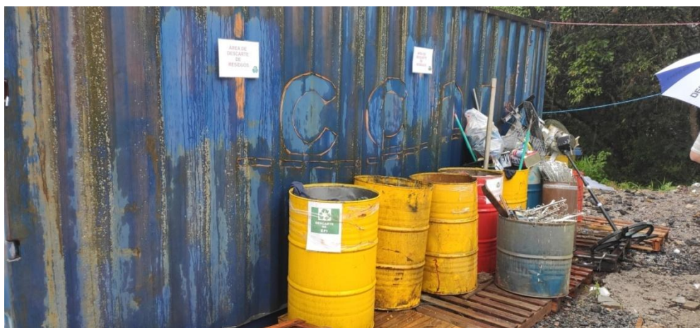
Figura 24. Descarte de EPIs e resíduos perigoso em local aberto, sem cobertura. Fonte: SMA
