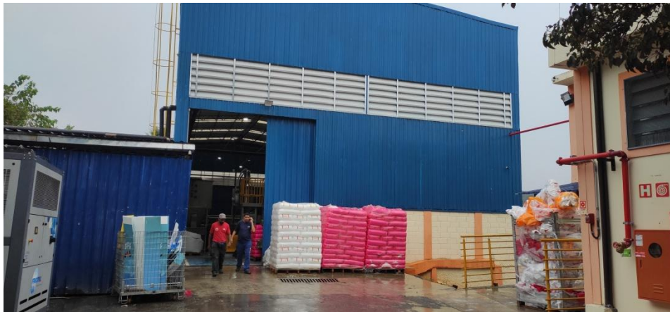
Figura 1. Galpão utilizado para ampliação do empreendimento. Fonte: SMA
