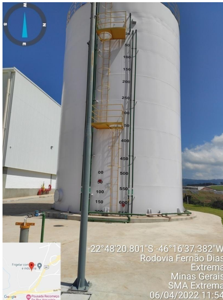
Figura 15. Poço tubular subterrâneo com outorga em andamento junto ao IGAM nº 1370.01.0024509/2021-67 consumo mensal máximo 50 m 3 /mês.
