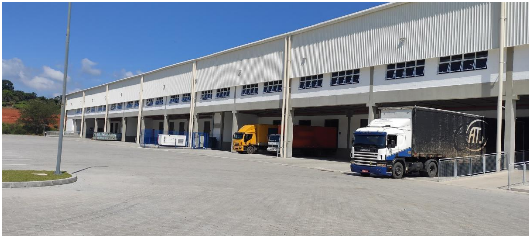
Figura 1. Visão geral da área externa empreendimento
