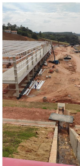
Figura 18. Drenagem Central/Norte em execução no momento da vistoria
