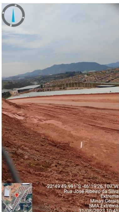
Figura 17. Talude nordeste com acesso G200 sem cobertura no momento da vistoria.
