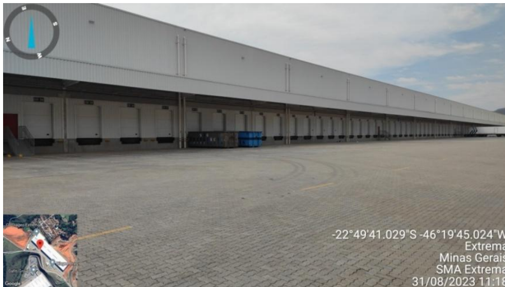
Figura 1. Visão da fachada externa dos módulos ocupados pelo empreendimento.
