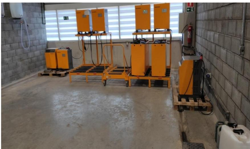
**Figura 3. Sala de carregamento de baterias**
