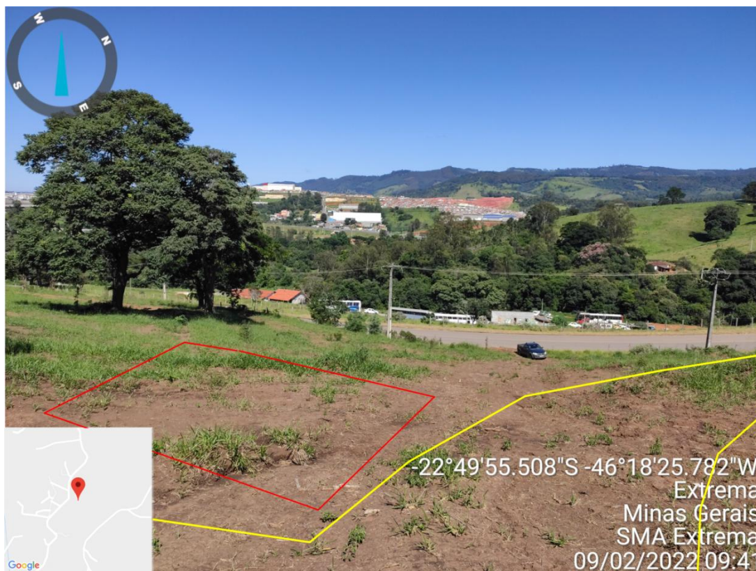
Figura 2. Vista da área central do empreendimento, onde será instalada rampa de acesso e guarita.
