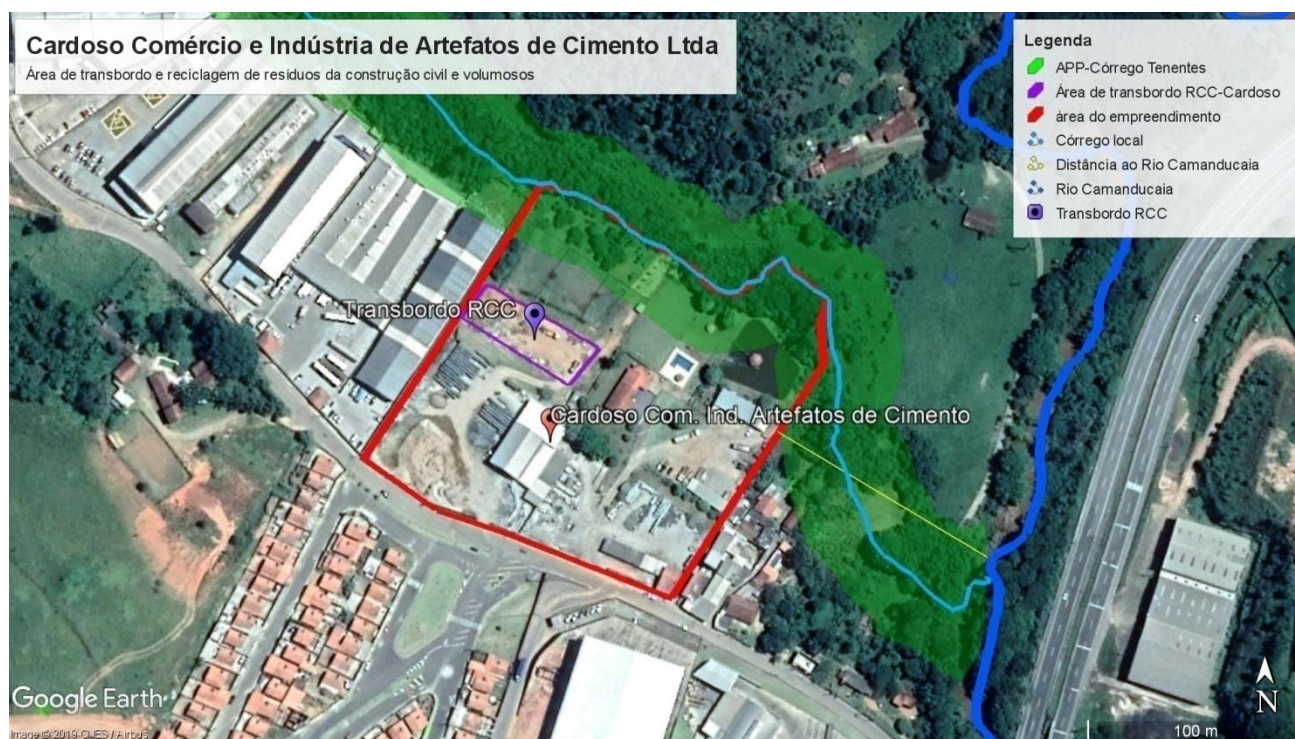
Figura 1. Localização do empreendimento (área de transbordo, triagem e reciclagem de resíduos de construção civil e volumosos). Fonte: Google Earth Pro, 2019.
