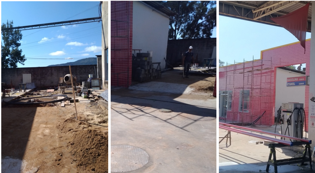
Figuras 1, 2 e 3. Área de lavagem de veículos, em construção.
