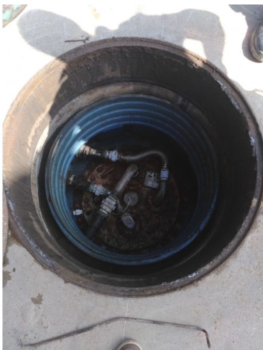
Figura 12. Área de visita do tanque de abastecimento de combustível (Diesel S-500)
