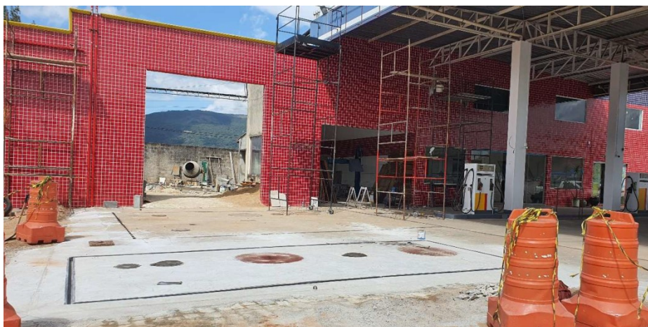
Figura 17. Instalação do tanque novo concluída
