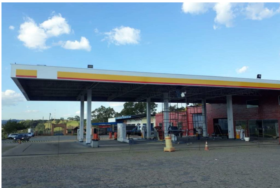
Figura 18. Finalização das instalações pela Distribuidora Shell
