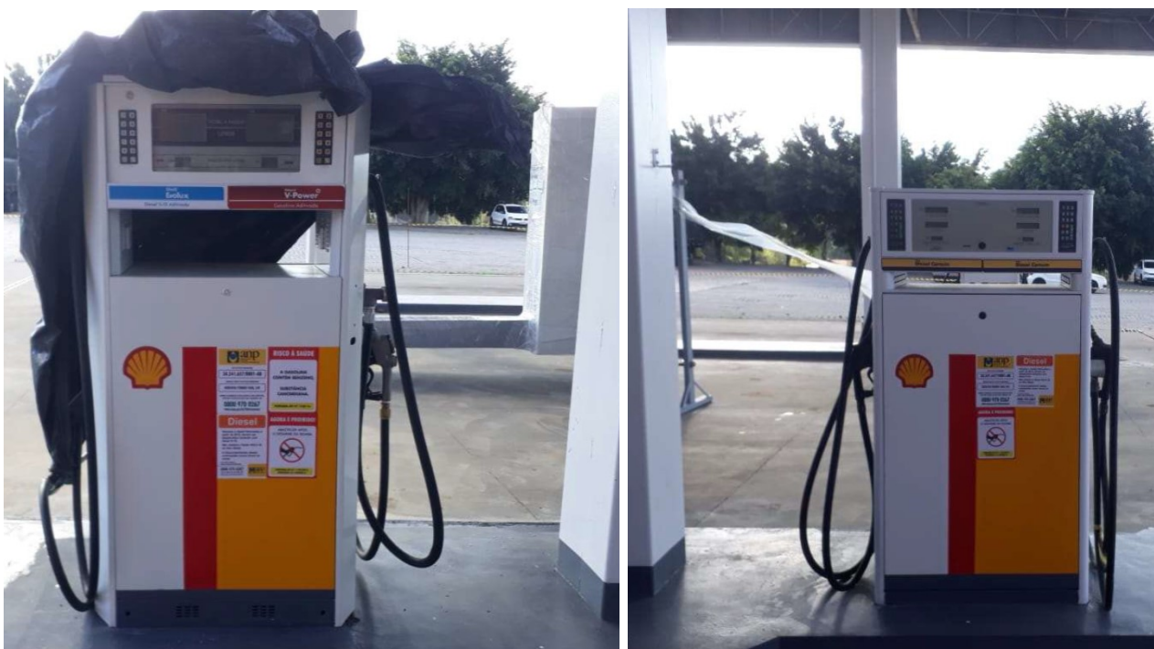
Figura 19. Instalação de bombas e unidades de abastecimento novas e para as novas linhas provenientes do novo tanque de 30 m 3 bipartido - gasolina aditivada / Diesel S10.
