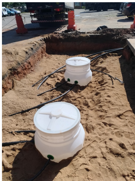
Figura 5. Tanque subterrâneos de combustíveis em instalação
