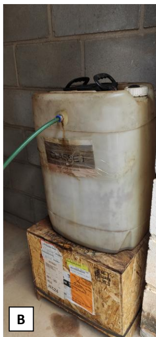
Figura 11. Compressor (A), coleta de água de purga (B) e tambor armazenado temporariamente para envio a destinação final (C)
