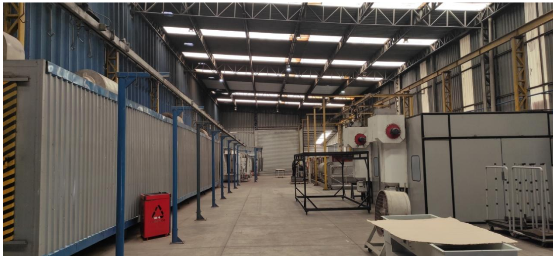
Figura 10. Setor de pintura a pó.
