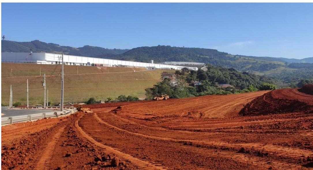
**Figura 4. Terraplanagem na entrada da parte sul do empreendimento.**
