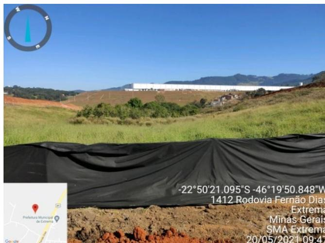
Figura 12. Manta geotêxtil de proteção da APP da nascente.
