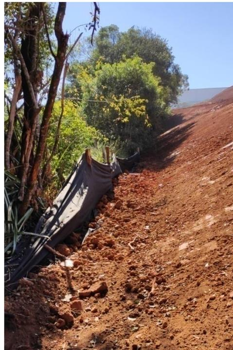
Figura 14. Manta geotêxtil instalada na margem esquerda do córrego local.
