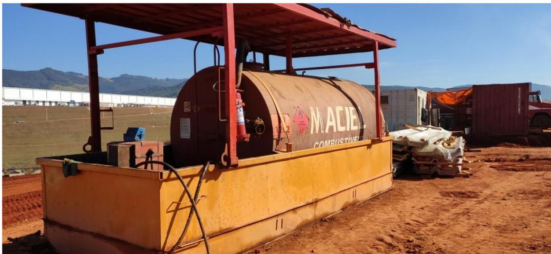
**Figura 3. Estação móvel/tanque aéreo de diesel.**
