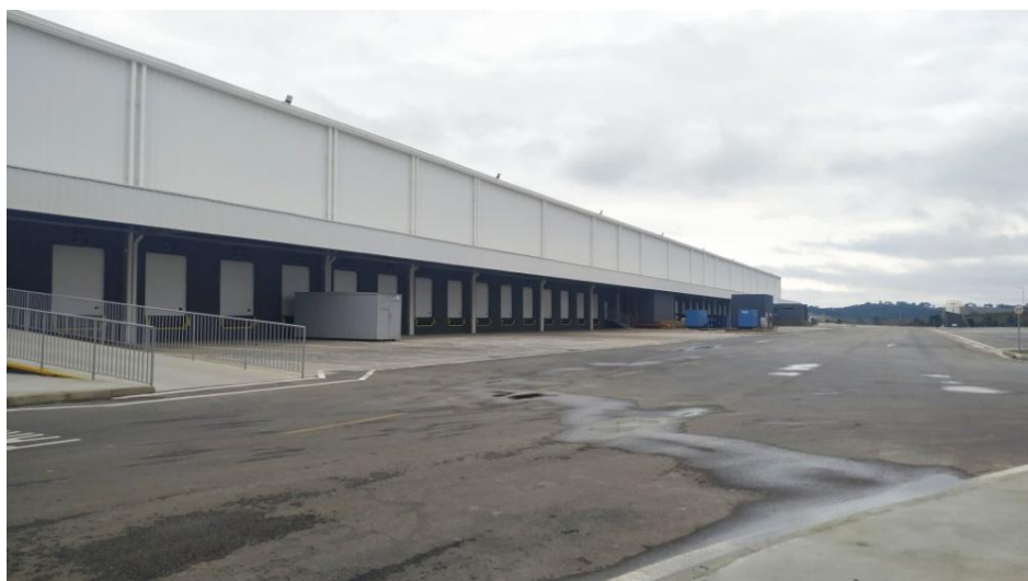
Figura 3. Área externa noroeste do centro de distribuição
