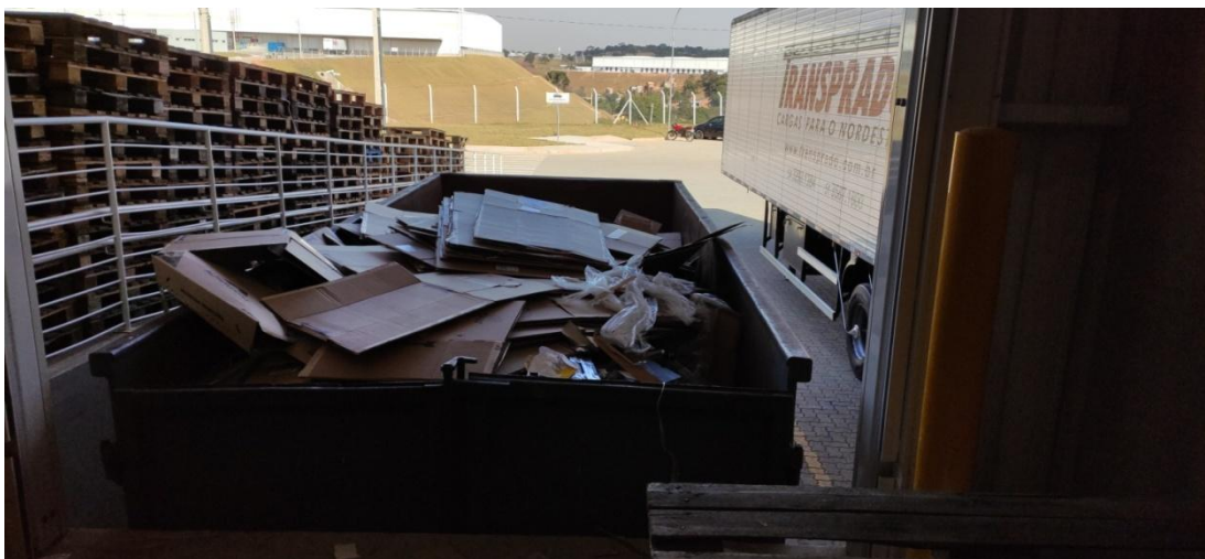
Figura 6. Armazenamento temporário de resíduos recicláveis do empreendimento
