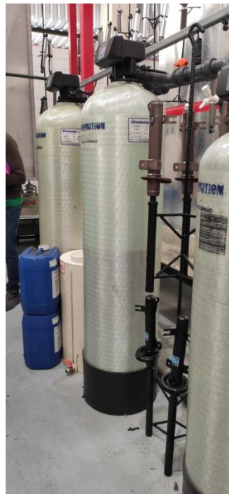
Figura 8. Sistema de produção de água deionizada.
