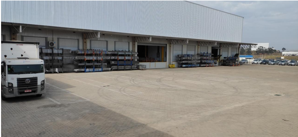
Figura 1. Galpão do empreendimento.
