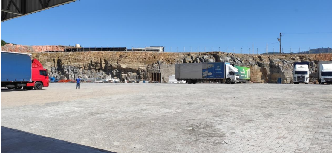
Figura 1. Área externa do empreendimento.
