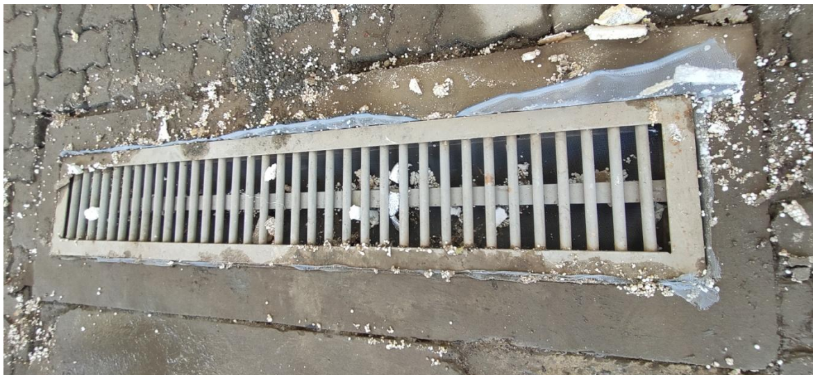
Figura 24. Sistema de contenção de partículas EPS nas saídas do sistema de drenagem.
