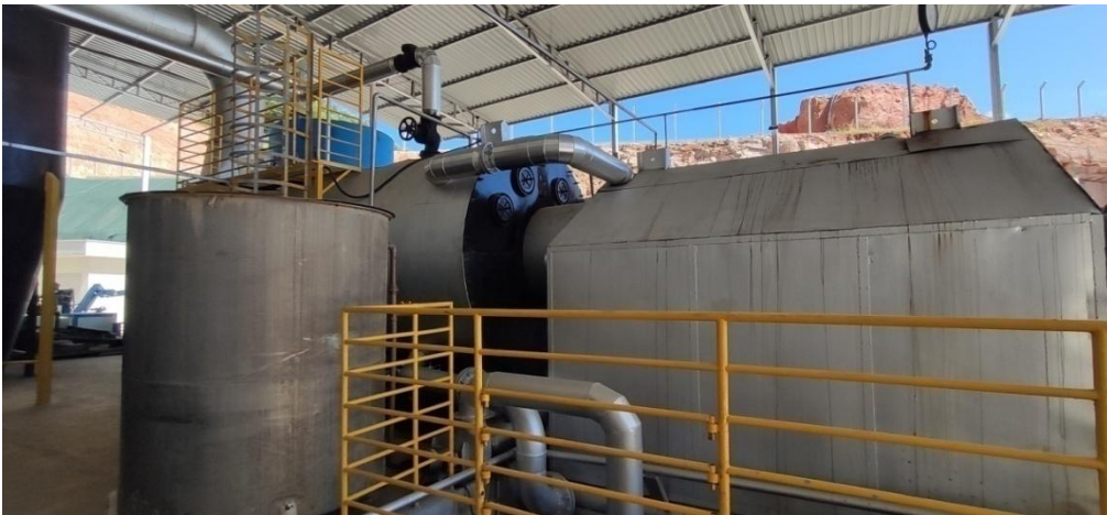
Figura 18. Caldeira utilizada para produção de vapor.
