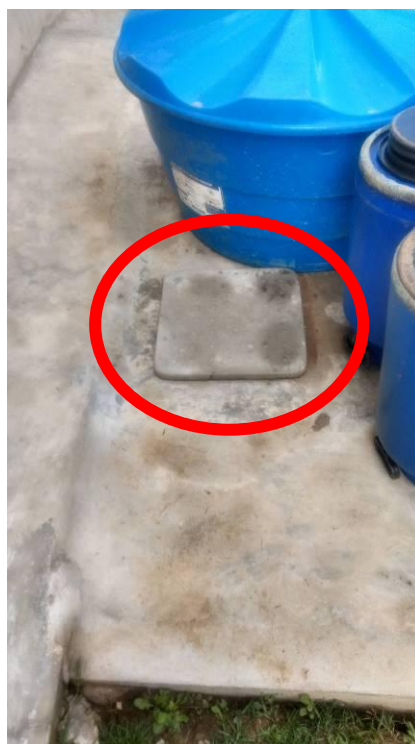
Figura 6. Caixa de gordura
