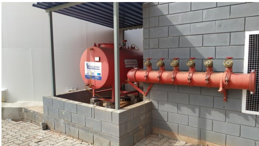
Figura 3. Localização de reservatório de Diesel S10 utilizado no gerador do condomínio, com bacia de contenção para prevenção em caso de vazamentos.
