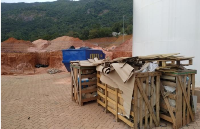
Figura 7. Local de armazenamento transitório de resíduos no momento da vistoria
