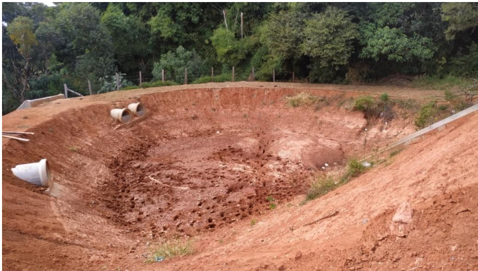
Figura 9. Tanque de contenção, localizado na porção leste do empreendimento, para captação de águas pluviais
