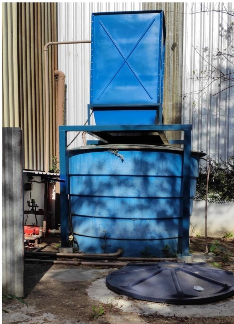
**Figura 8. Sistema de reutilização da água de processo**
