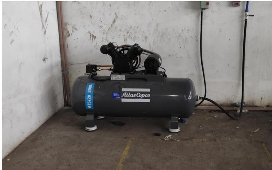
Figura 9. Área do compressor, sem baia de contenção
