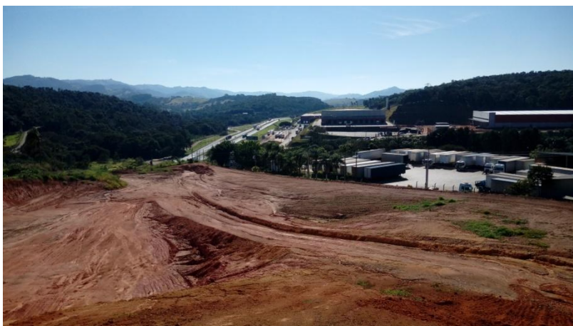
Figura 3. Vista da porção leste do terreno do empreendimento, com vista do pátio de empreendimento vizinho.
