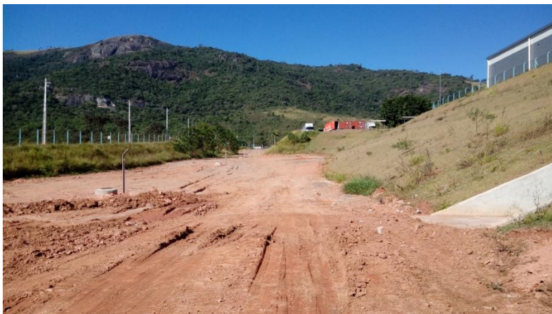
Figura 1. Vista do local de acesso à área do empreendimento.
