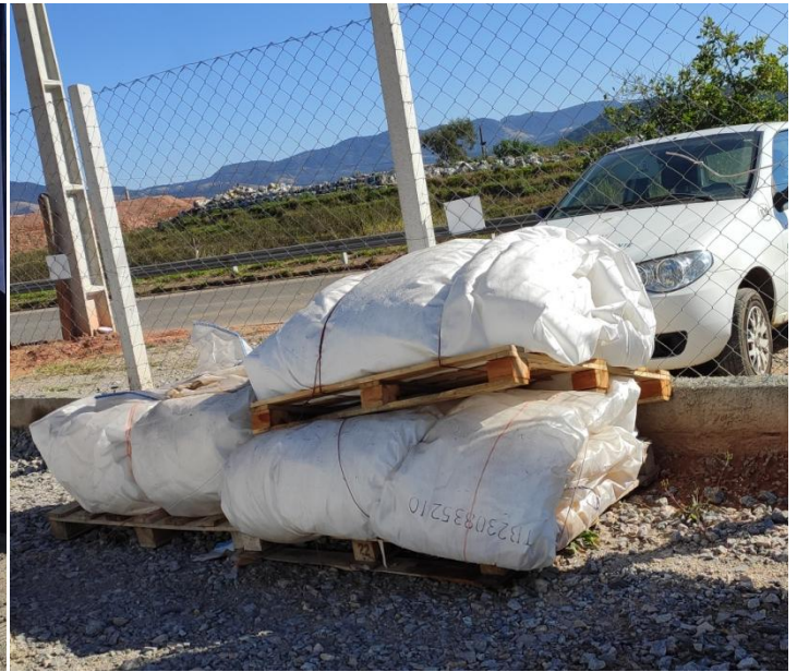
Figura 17. Local de armazenamento temporário de sacos de rãfia
