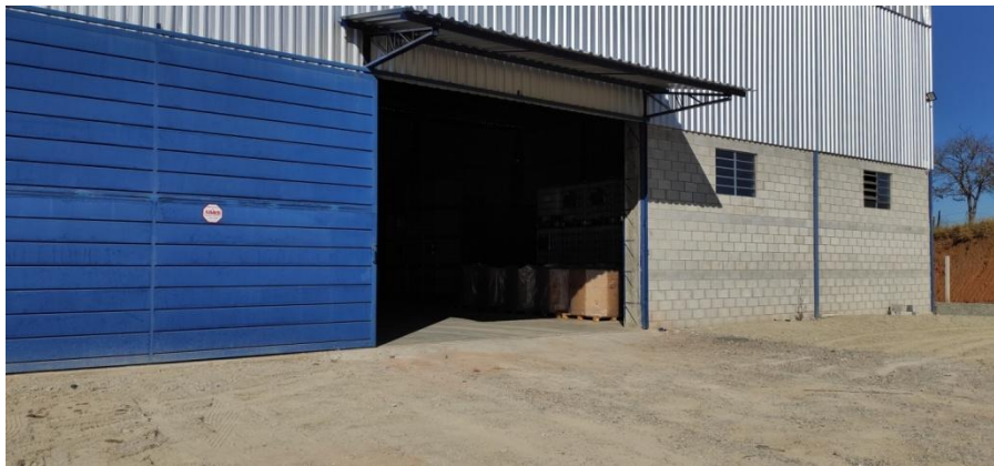
Figura 1. Vista externa do galpão
