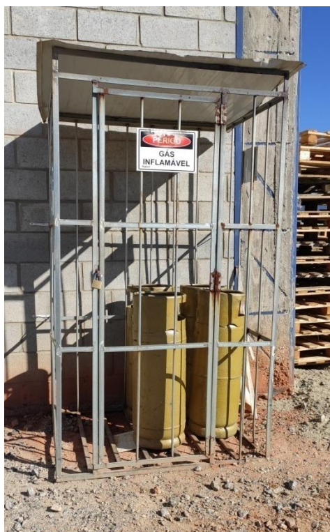
Figura 11. Local de armazenamento de botijões GLP.
