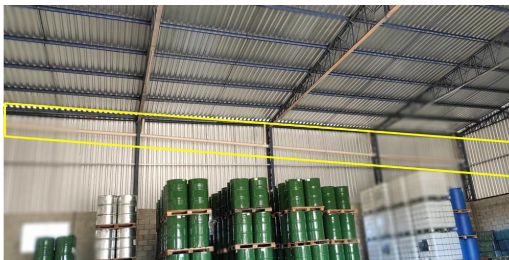
Figura 14. Tubulação do sistema de drenagem.
