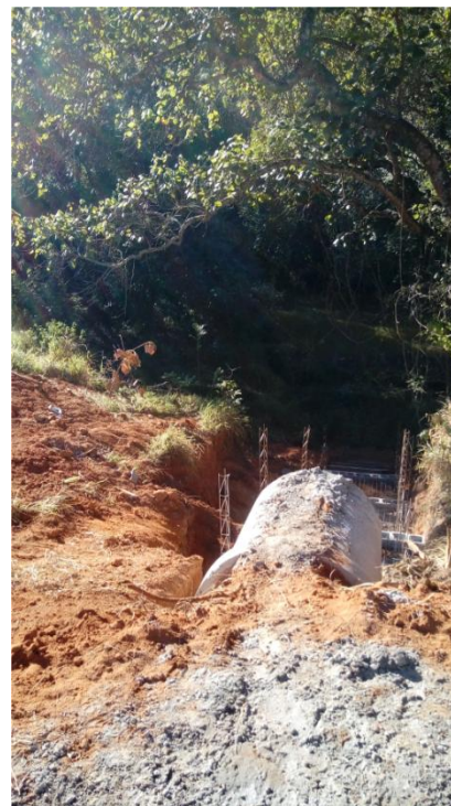
Figura 9. Escada hidráulica do Lot. Parque dos Jatobás em instalação (lançamento conjunto com o loteamento em licenciamento)
