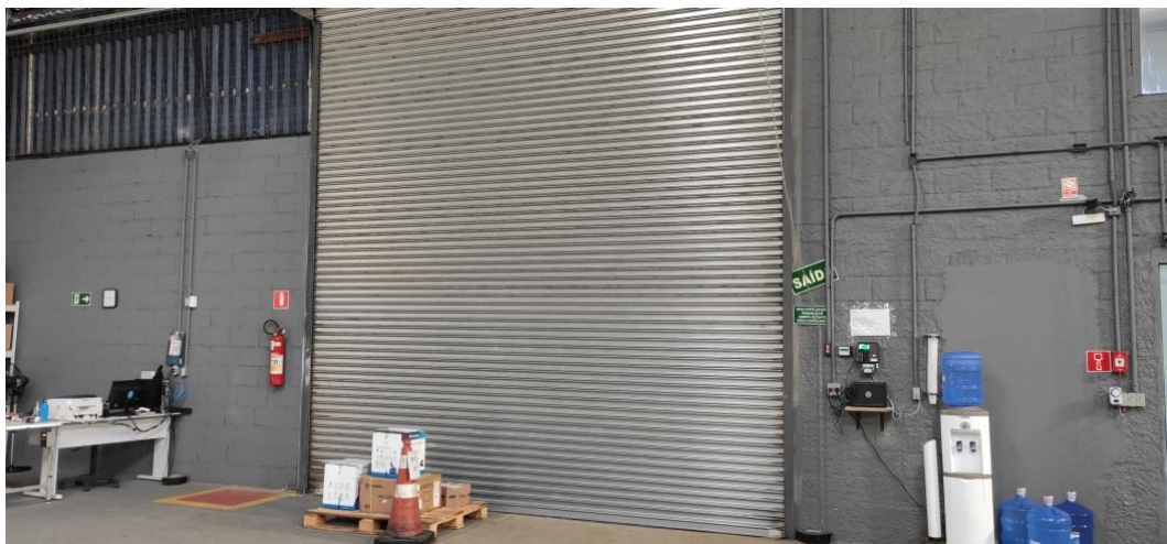
Figura 1 . Área de recebimento/expedição, vista interna.
